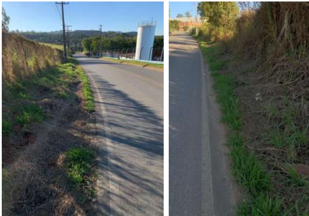
Figura 12 – Ausência de passeio público na Rua Armelina Pereira de Souza, acervo pessoal.
