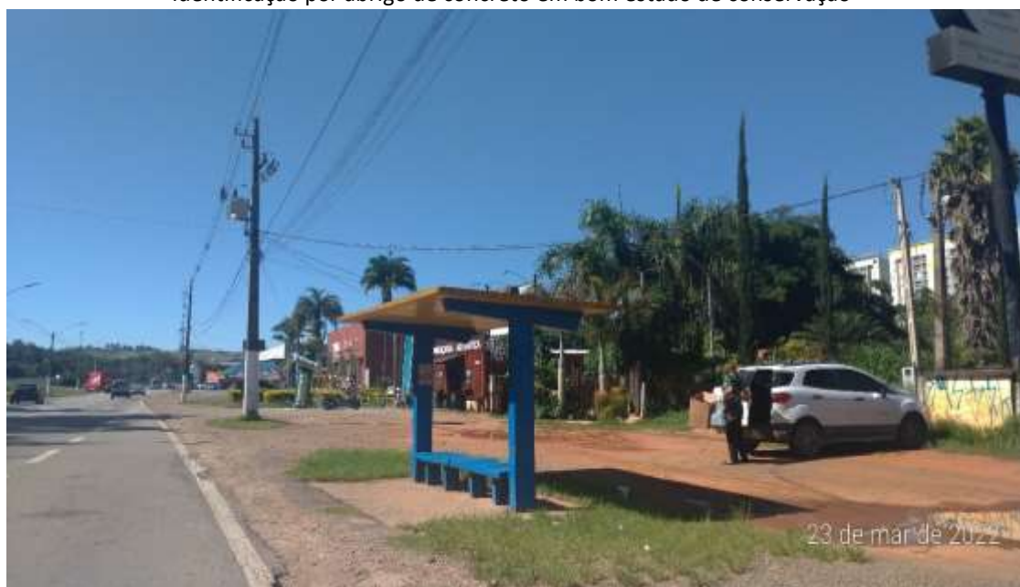
Figuras 3.8 a 3.11 – Pontos de parada de ônibus identificados na Área de Influência 3.8 – Ponto 1 – ROD. SPA-021/010 (sentido Bairro) Identificação por abrigo de concreto em bom estado de conservação
