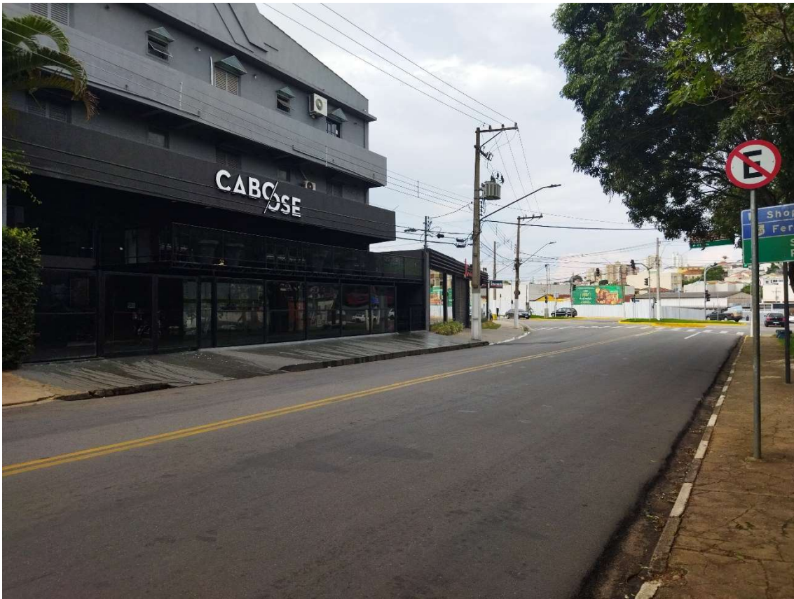
Figura 8- Vista lateral a partir da Av. Europa.
