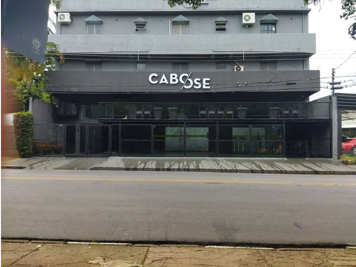
Figura 5- Foto da Fachada.
