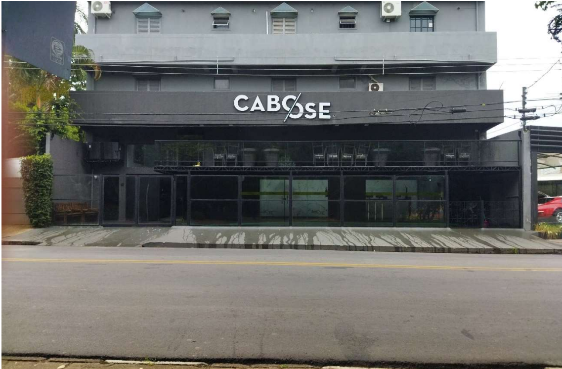
Figura 6- VISTA FRONTAL DA FACHADA
