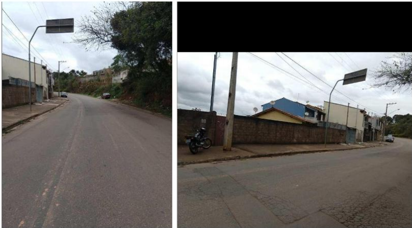
RUA ALZIRO DE OLIVEIRA – SENTIDO SUL (CENTRO)
