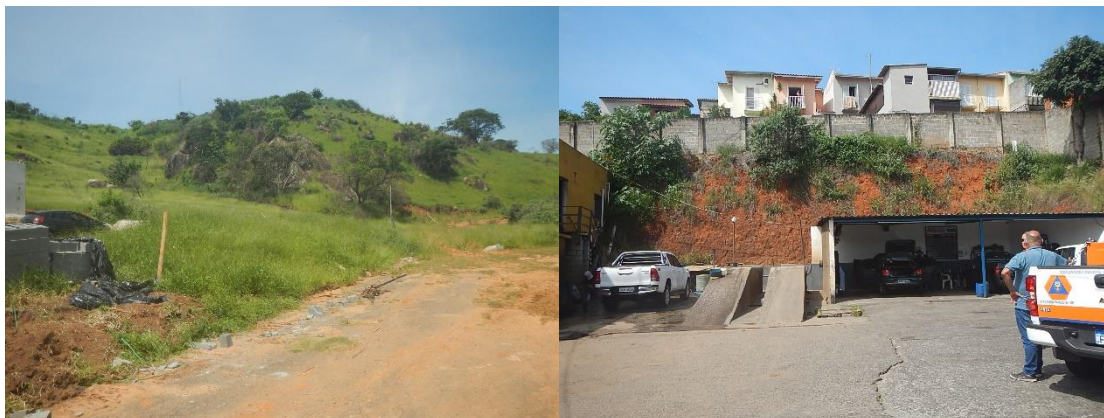
Figura 2: Presença de blocos de rocha granítica, à Av. João da Silva Leme, condição comum no município. Figura 3: Imóvel na Rua Uruguaiana, construído em terreno acidentado que faz uso de técnica inapropriada, onde grande talude de corte foi executado sem critérios técnicos.
