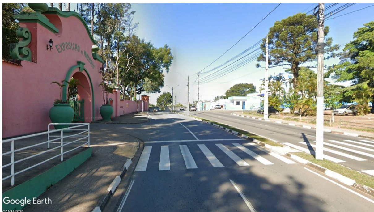
Figura 18. Quadras limítrofes ao empreendimento.
