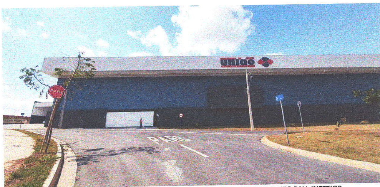
FACHADA DO IMÓVEL, VISTA PELA RUA ROSA BRANCA – ACESSO AO ESTACIONAMENTO PAV. INFERIOR
