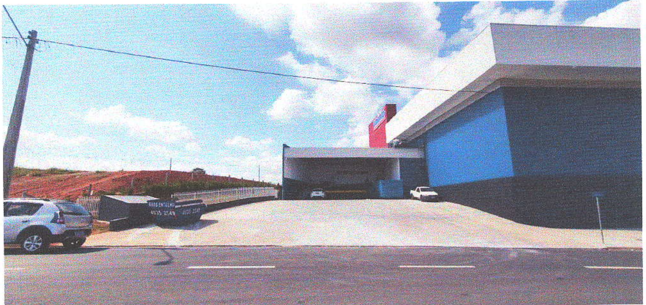
VISTA PELA RUA ROSA BRANCA – ACESSO AS DOCAS – ÁREA DE CARGA E DESCARGA DE MERCADORIAS
