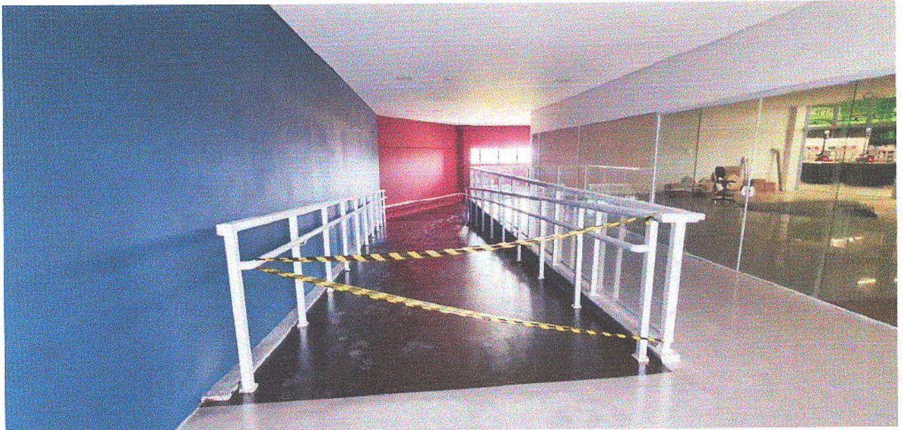
RAMPAS DE PEDESTRES
