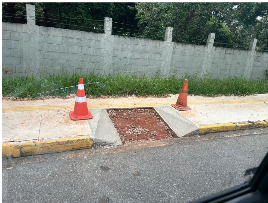
Imagem 34: Acesso calçada Av. Antonio Pires Pimentel sendo adaptada. Data: 03/02/2024
