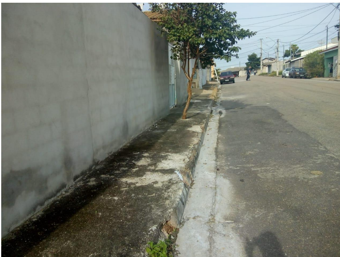
Figura 35: Calçada na rua do empreendimento. Fonte: Própria, 2019.
