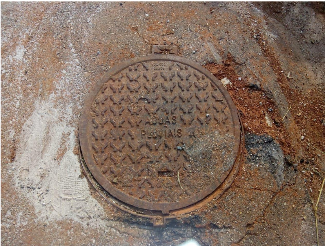
Figura 30: Galeria de águas pluviais Fonte: Própria, 2019.
