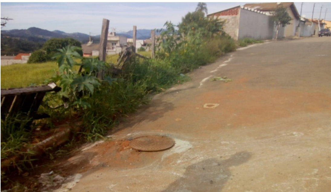
Figura 31: Galeria de água pluvial na entrada do empreendimento. Fonte: Própria, 2019.
