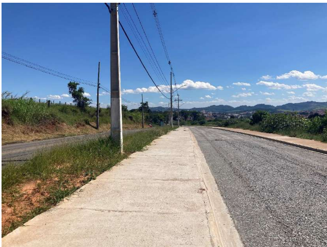
Figura 14. Vista geral da Av. Atílio Menin em obra para duplicação.
