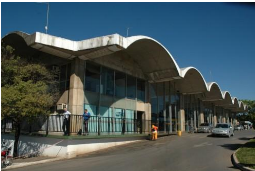
Figura 5 - Terminal Rodoviário de Montes Claros. Montes Claros/MG
