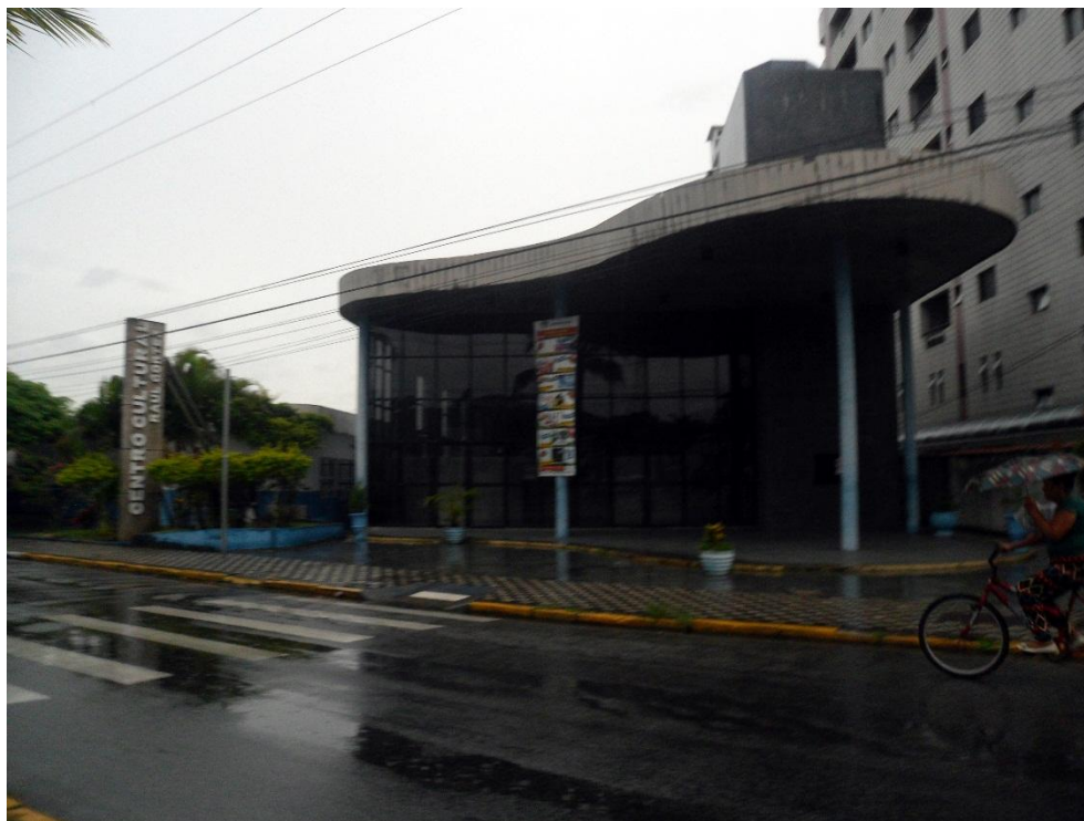
Figura 23 - Fachada do Centro Cultural Raul Cortez
