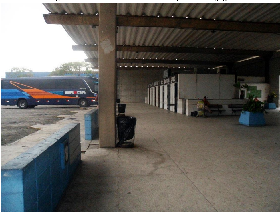
Figura 3 - Terminal Rodoviário Municipal de Mongaguá
