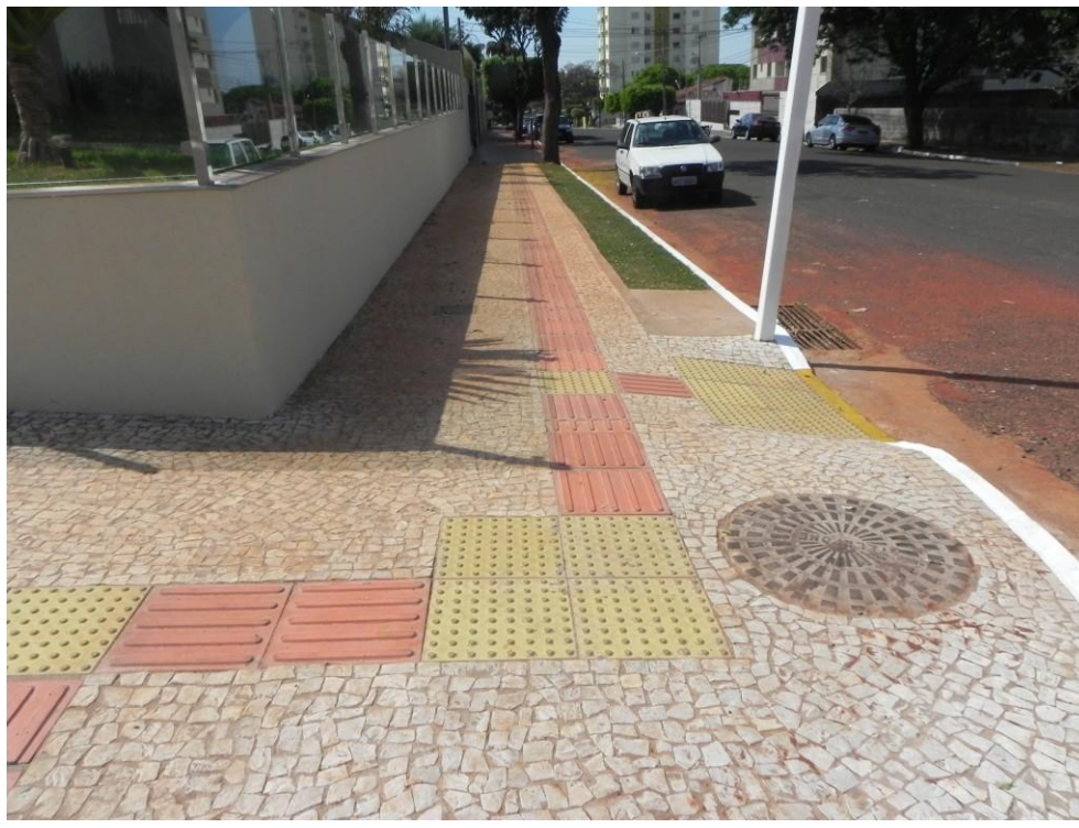
Figura 9 - Calçada Rua Eduardo Santos Pereira - Campo Grande/MS
