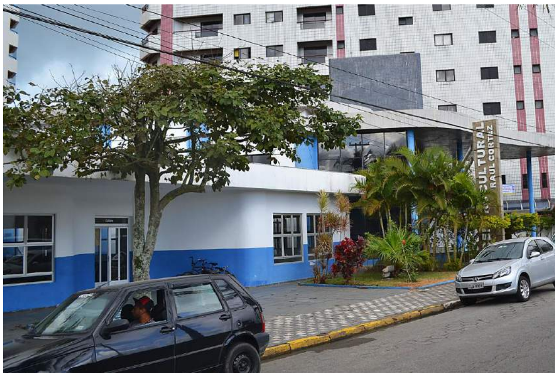
Figura 24 - Anexo do Centro Cultural Raul Cortez
