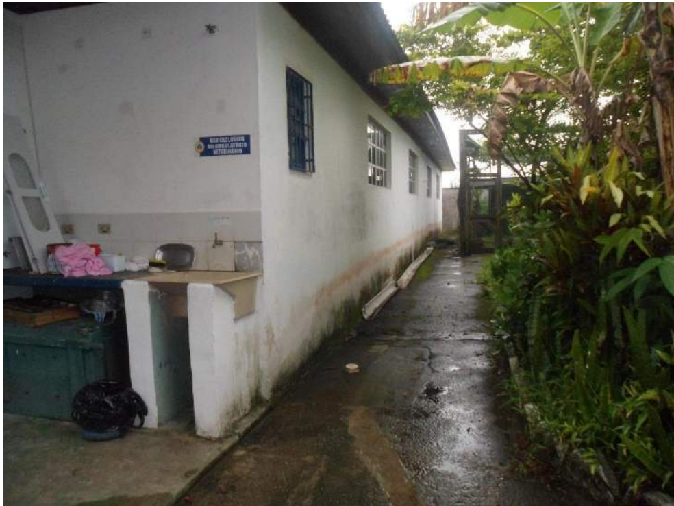
Figura 35 - Anexo com Refeitório dos Funcionários e Biotério dos Animais
