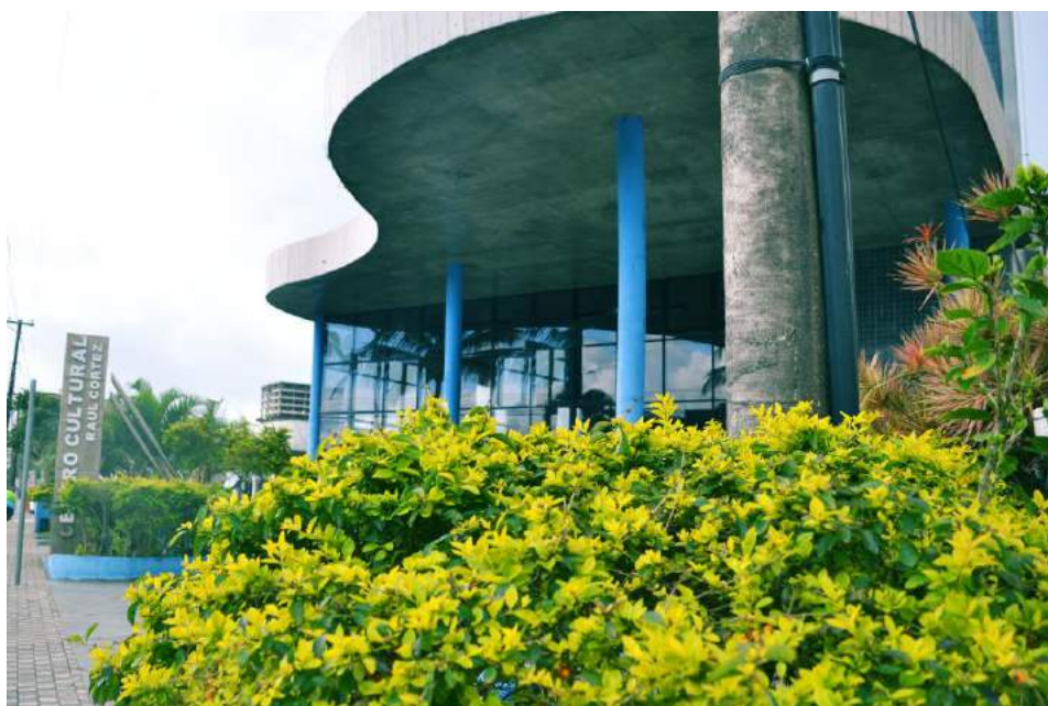
Figura 22 - Fachada do Centro Cultural Raul Cortez
