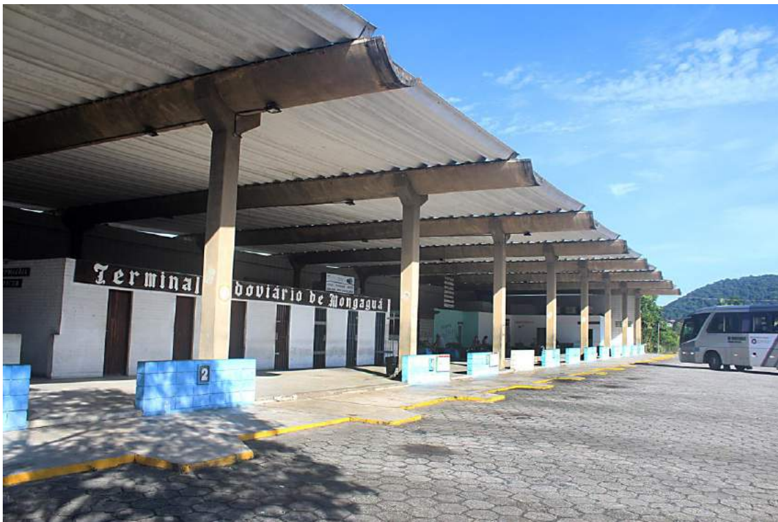
Figura 2 - Terminal Rodoviário Municipal de Mongaguá
