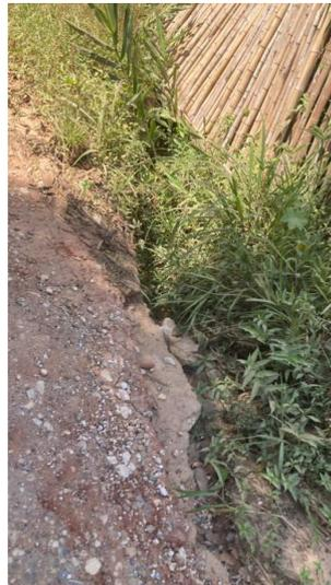
Foto 29 - Drenagem a ser executada na localização de 520m a partir do E00 (Verificar projeto)
