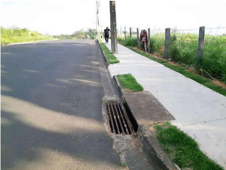
**Foto 07** – Sistema de drenagem e pavimentação de passeio existente na Rua Santa Maria, no lado oposto ao empreendimento. Boas condições de acessibilidade. Fonte: Flektor Urbanismo.
