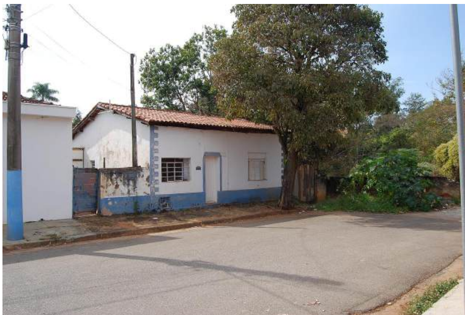
Foto 06 - Acesso pela Rua João Anfe.
