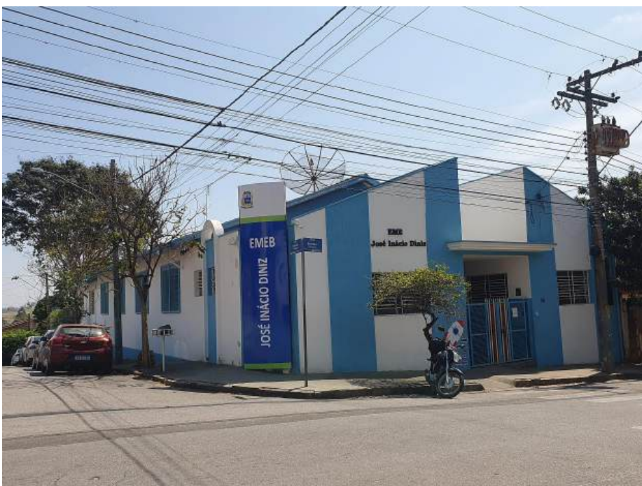
Foto 26 – Vista da EMEB José Inácio Diniz, a menos de 50 metros do empreendimento.
