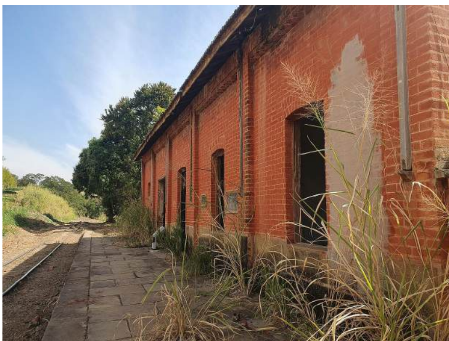
Foto- 20 - Antiga Estação Ferroviária e armazém bairro Alegre.
