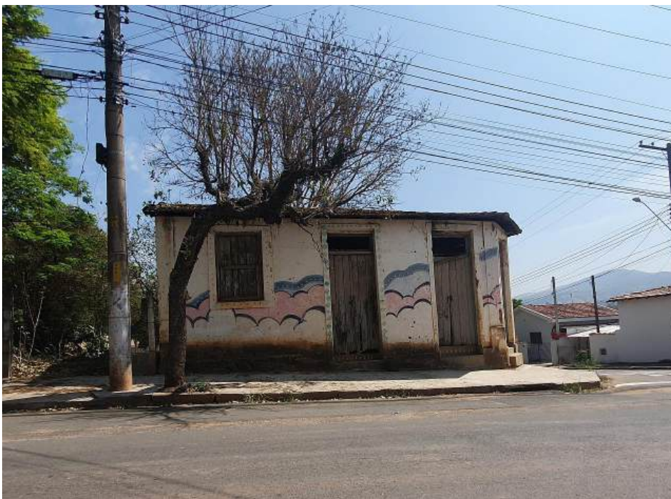
Foto 25 – Vista de antiga construção, a ser mantida como patrimônio arquitetônico e cultural.
