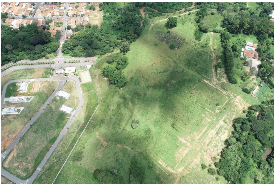
Foto 25 – Vista aérea da gleba e de seus vizinhos imediatos. À esquerda o Condomínio Pôr do Sol. Fonte. Notar a abertura das vias de demarcação das quadras feitas pelo proprietário anterior após a emissão do CERTIFICADO GRAPROHAB. Tag Geo Engenharia.
