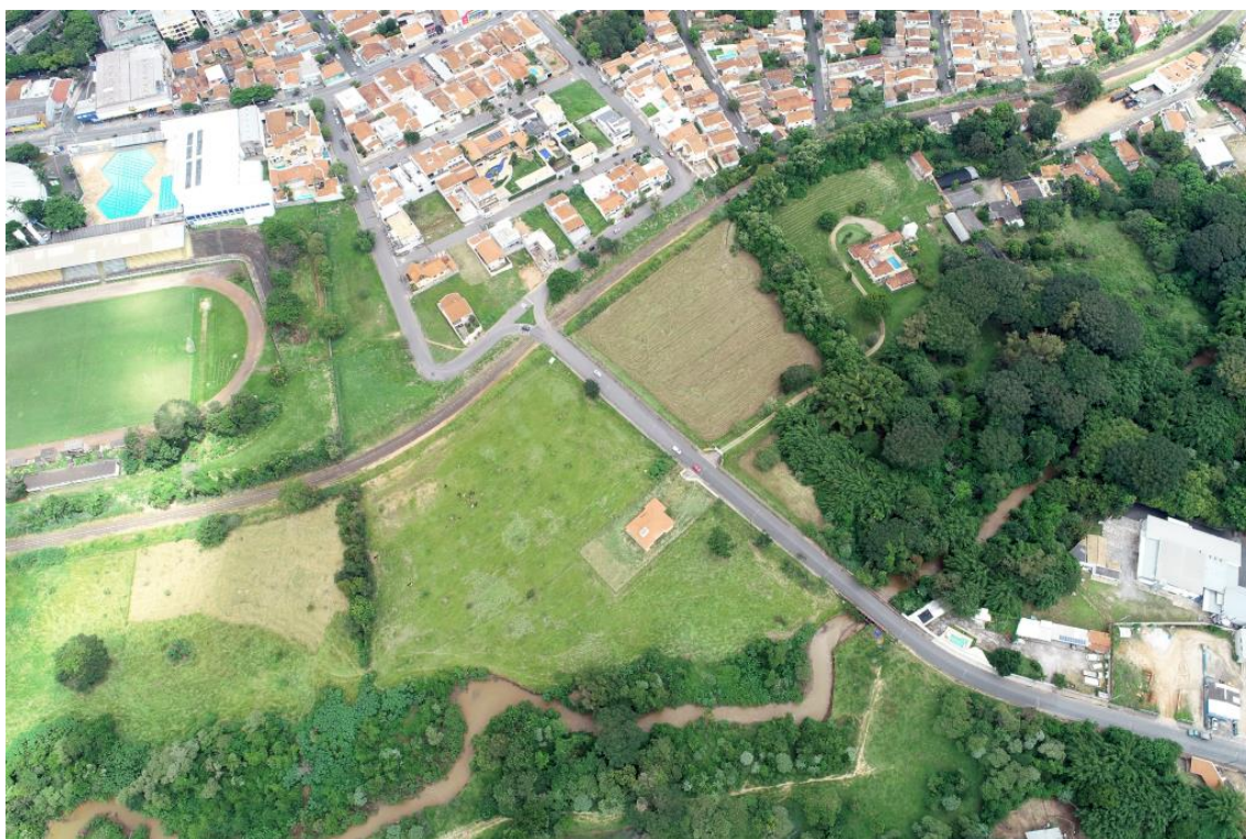
Foto 27 – Vista aérea da gleba da AID e AVI do empreendimento. Fonte. Tag Geo Engenharia.
