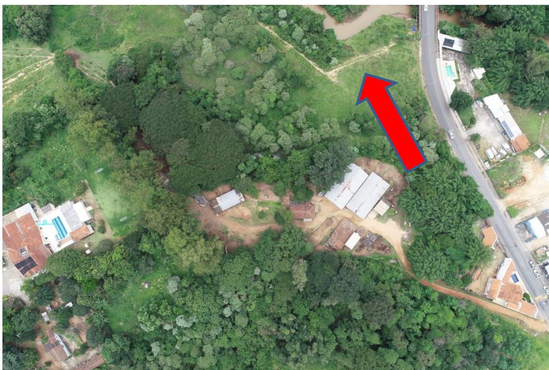
Foto 22 – Vista aérea do local onde haverá o novo acesso à Av. Pedro Rezende Lopes. Fonte: Tag Geo Engenharia.
