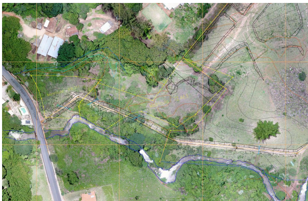
Figura 44 – Novo acesso ao loteamento Rua 1 – com 18,00 metros de caixa interligada à Av. Pedro Rezende Lopes.
