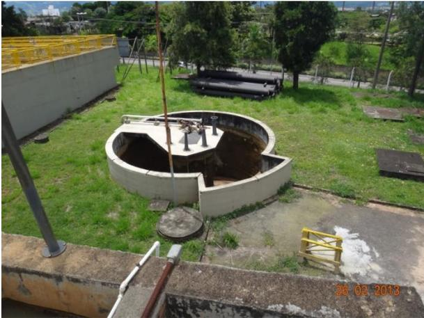
Foto 4.9 - Tanque de recuperação da água de lavagem dos filtros.
