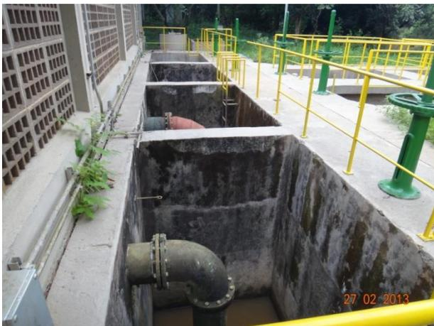
Foto 4.3 - Poço de sucção - EEAB1.
