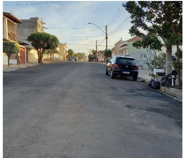
Figura 91 - Condições de Pavimentação
