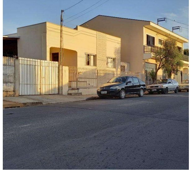
Figura 84: Condições de arborização 4
