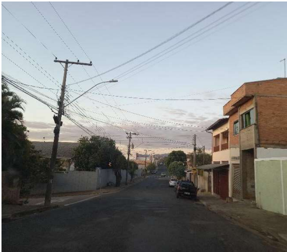
Figura 90 – Condições de Pavimentação 1
