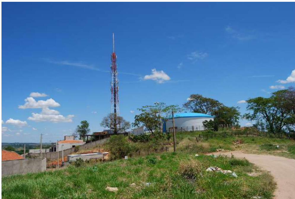
Foto 07 – Vista da Caixa D'água da Sabesp, na AVI. O. Fonte: Flektor Urbanismo.
