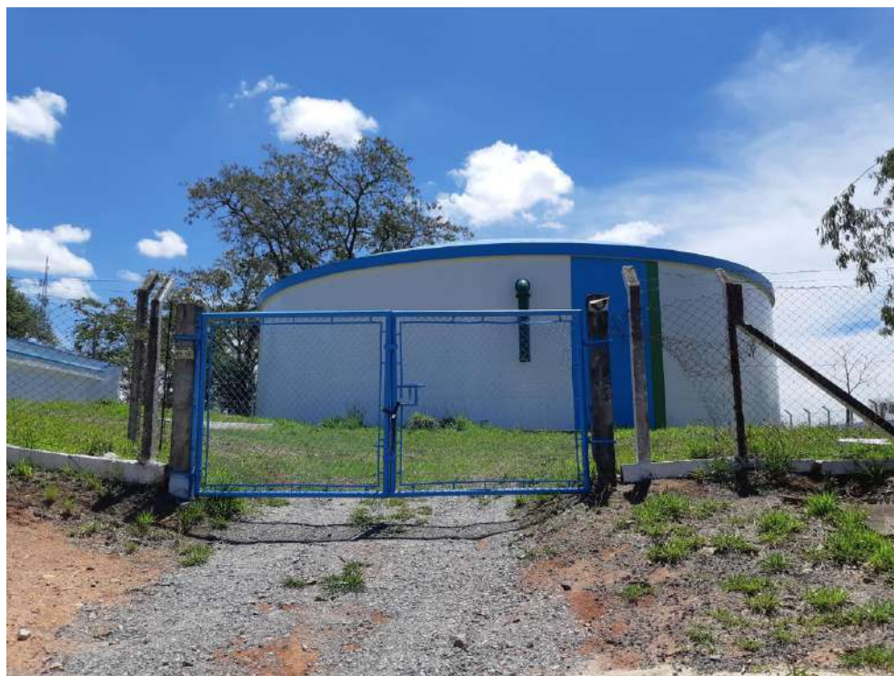
Foto 11 – Caixa D'água da Sabesp – vizinho imediato Fonte: Flektor Urbanismo.
