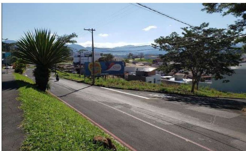
Figura 48: Situação dos passeios públicos em lotes desocupados da Av. Dr. Durval Nicolau. Fonte: Acervo do autor deste relatório.
