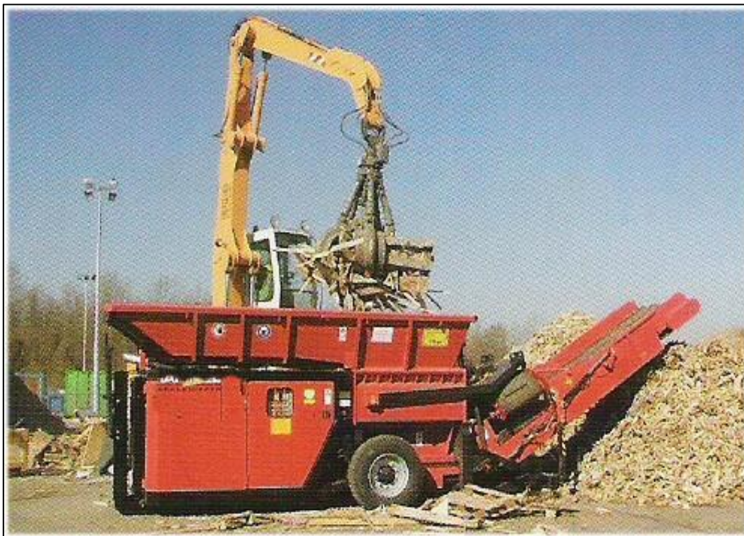
Figura 52: Triagem e britagem de RCC. Fonte: São Paulo, SMA e CETESB (2010).
