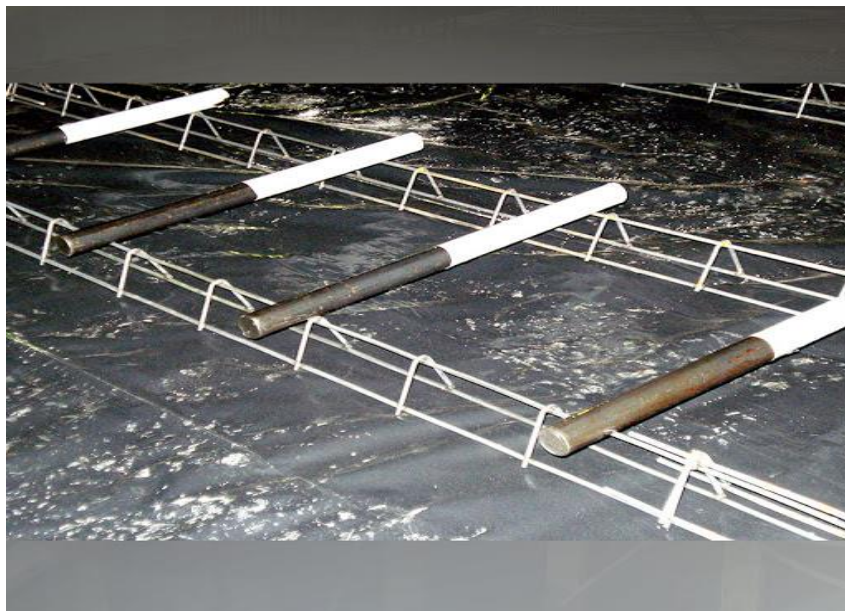
Figura 07 – Posicionamento das barras de transferências com o uso de espaçadores metálicos.
