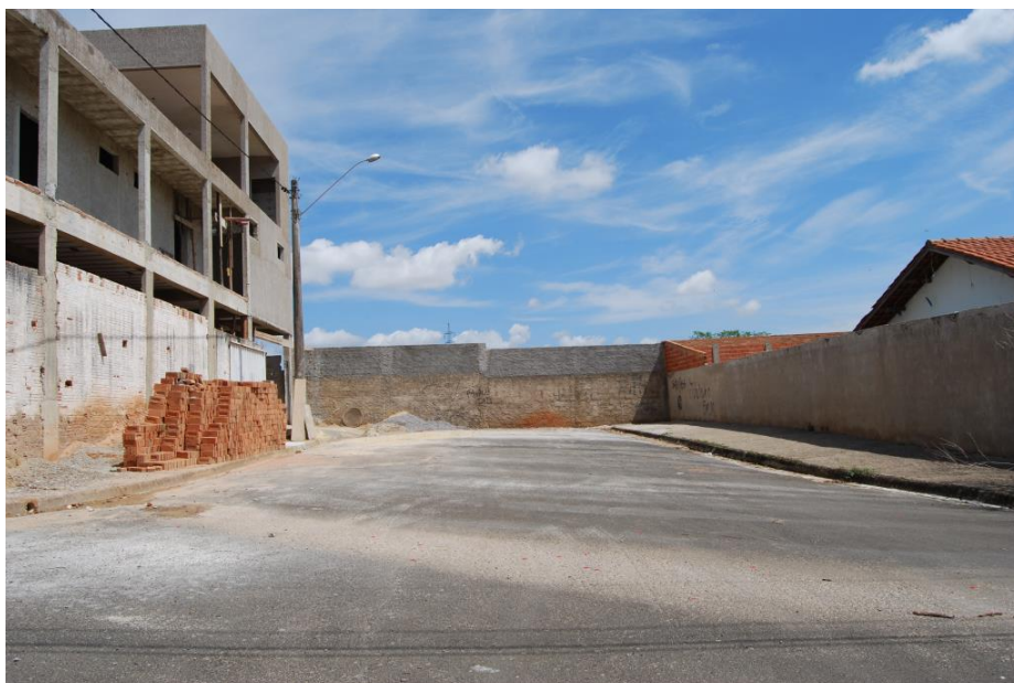
Foto 04 – Subsetor 1 – Rua Romildo Ferreira Silva, que deverá ser estendida e integrada com o Loteamento Guiomar Novaes. Nota-se à esquerda que o imóvel original já foi completamente descaracterizado de sua concepção original. O bairro deixa, pouco a pouco, sua aparência popular para se transformar em um bairro de classe média.
