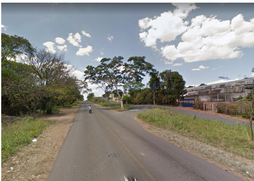
Foto 62 – Dispositivo de entrada e saída do jardim Itália. Não há pista de desaceleração e nem sinalização vertical.
