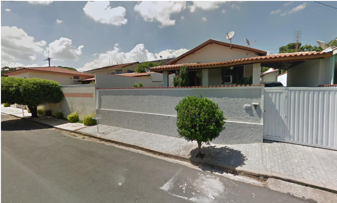
Foto 43 – O Subsetor 9 apresenta maior variedade de tamanhos de lotes e de padrões construtivos.
