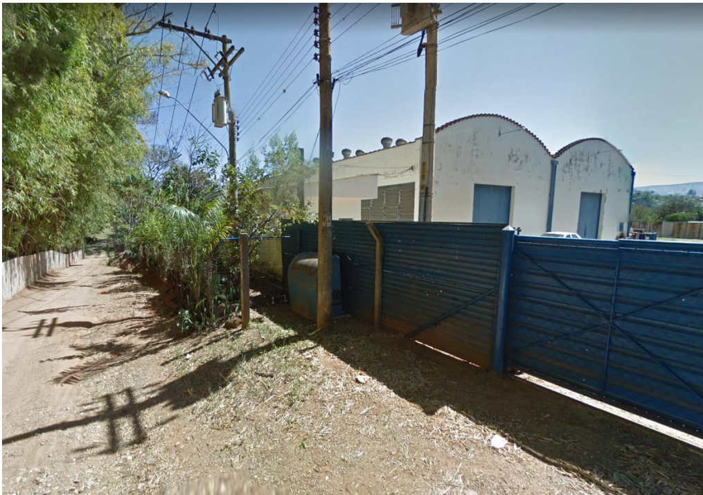
Foto 06 – Indústria existente no Subsetor 2. Rua Francisco Romera Valverde, bairro Jardim São Manoel.
