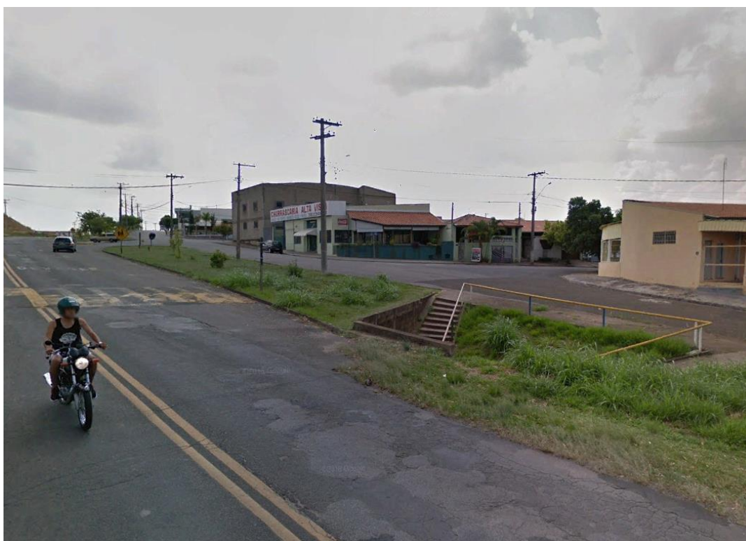
Foto 58 – Vista da estrada, da passagem subterrânea de pedestres e da faixa de desaceleração para acesso ao jardim Maestro Mourão, implantada sobre a faixa de acostamento. Nota-se também a lombada para redução de velocidade.
