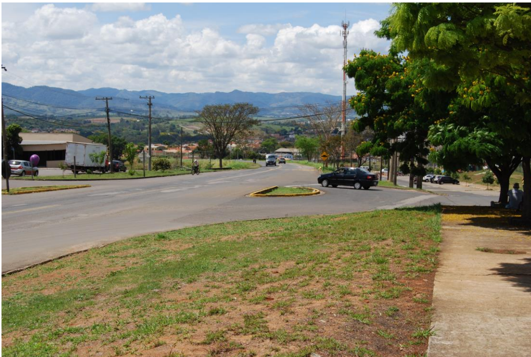
Foto 54- Dispositivo de acesso ao SESI e IFSP Jardim Maestro Mourão. Exemplo de veículo acessando o Jardim Maestro mourão enquanto outro cruza a pista da estrada.
