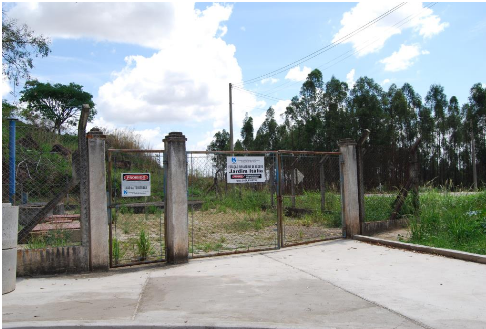
Foto 25 – Estação Elevatória de Esgotos do Jardim Itália.
