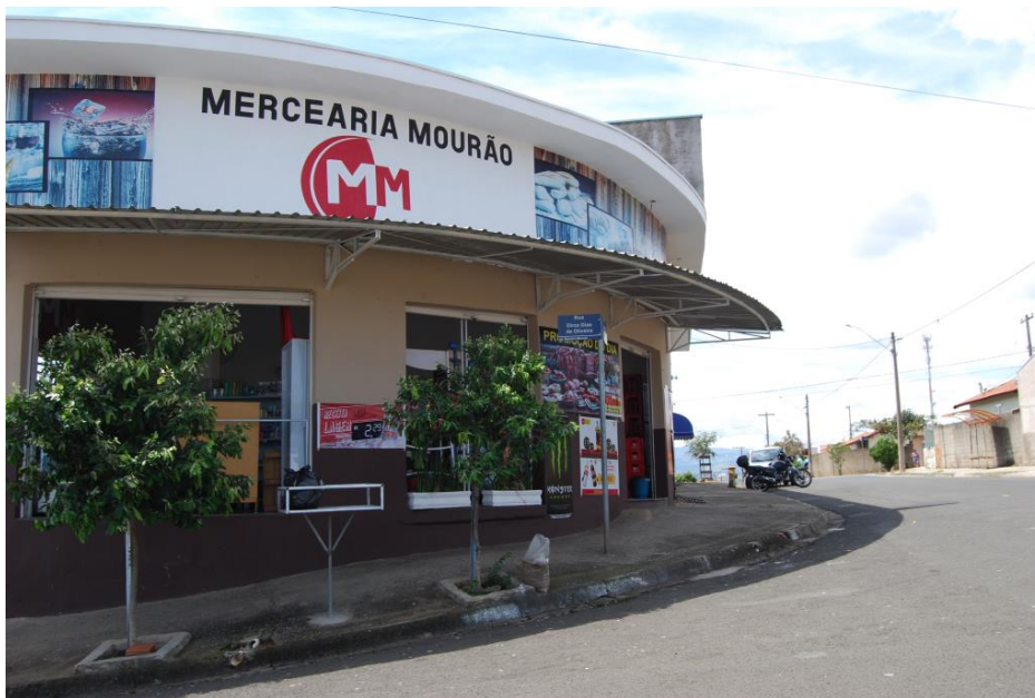
Foto 01 – Subsetor 1 – Exemplo de uso comercial existente no Subsetor 1. Rua Dirce Dias de Oliveira.
