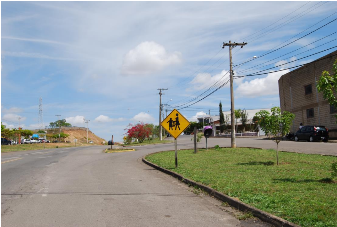
Foto 51- Dispositivo de acesso ao Jardim Maestro Mourão. Possui pista de desaceleração e sinalização vertical e horizontal.
