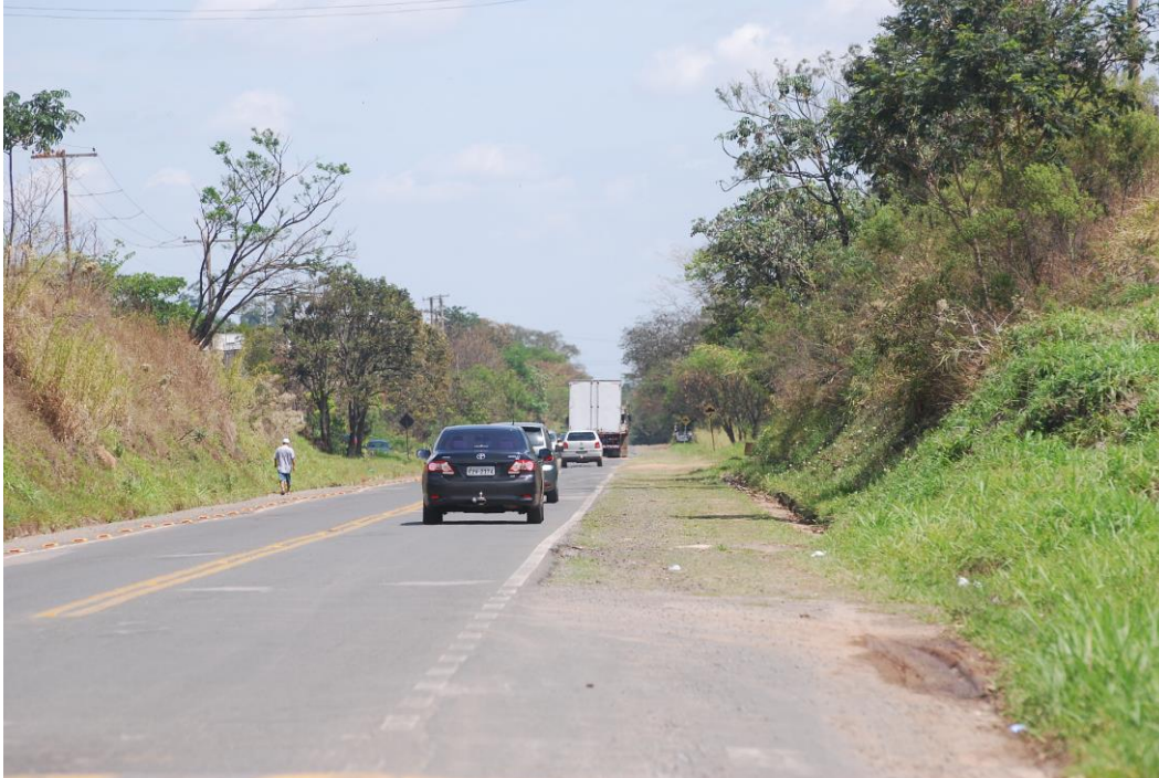
Foto 48 - Vista da Estrada Vicinal João Batista Merlin. Notar a sinalização horizontal e a existência de tachas no acostamento para proteção de pedestres. A melhoria da sinalização para alertar sobre a circulação de pedestres é recomendada.
