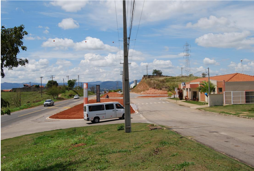
Foto 59 – Dispositivo de acesso e saída dos equipamentos institucionais de saúde e educação existentes.
