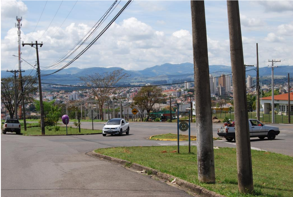
Foto 53- Dispositivo de acesso ao Jardim Maestro Mourão. Exemplo de veículo acessando o Jardim Maestro mourão enquanto outro cruza a pista da estrada.
