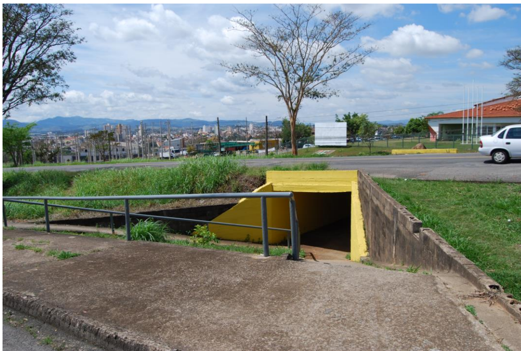
Foto 57 – Passagem subterrânea para pedestres. Em estado de conservação embora as luminárias tenham sido vandalizadas.
