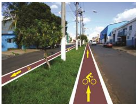
CICLOVIA NA AV.RIBEIRÃO PRETO
