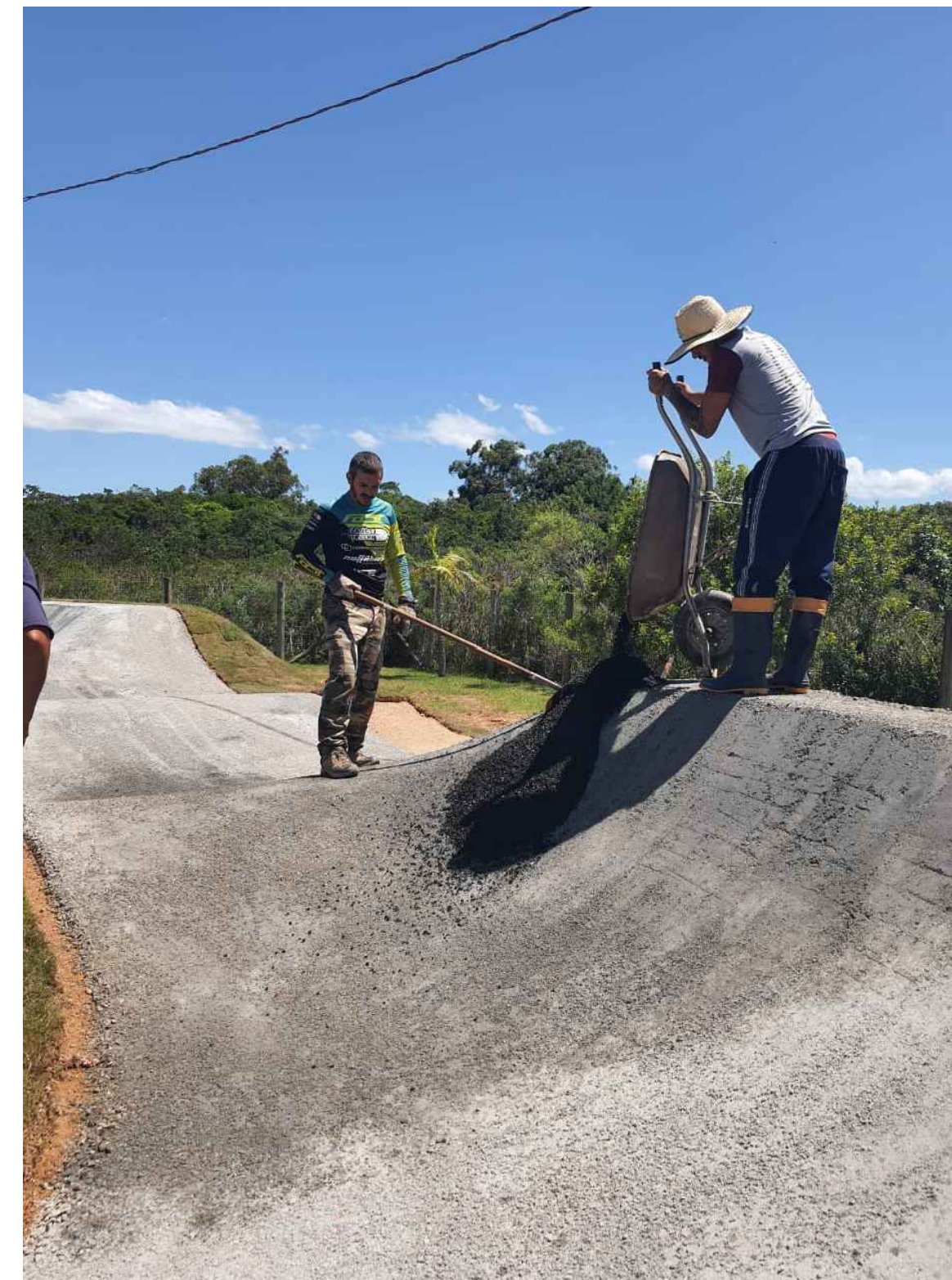
ILMAGEM ILUSTRATIVA EXECUÇÃO DE BASE BGS
