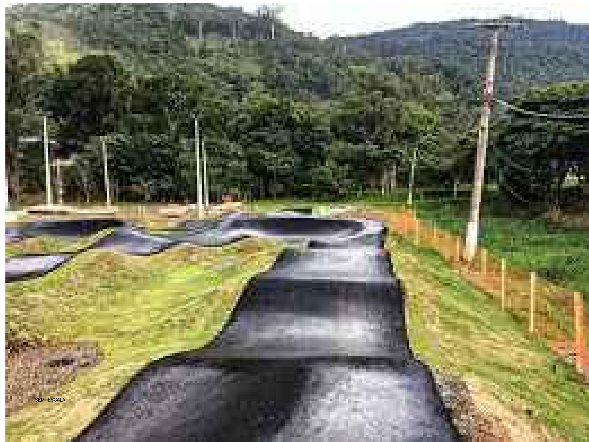
ILMAGEM ILUSTRATIVA ONDULAÇÕES DO PAVIMENTO
