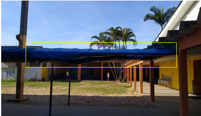
Reforma da metade do toldo 6m x 2,40m que dá acesso a quadra. Troca da lona.
