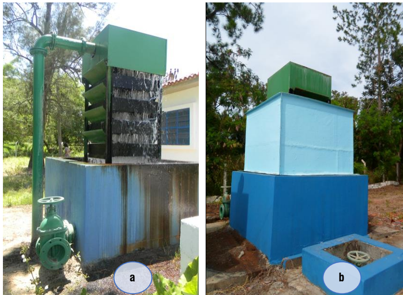
Figura 16 – Poço P8: a) torre de Aeração; b) filtro.
