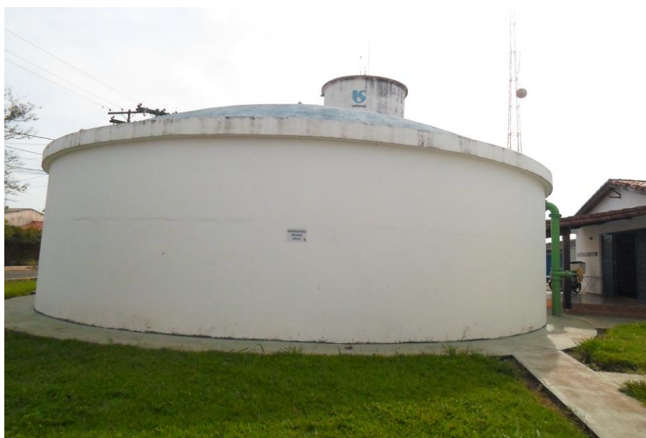
Figura 30 - Reservatório de 500 m 3 (Unidade de Filtragem).
