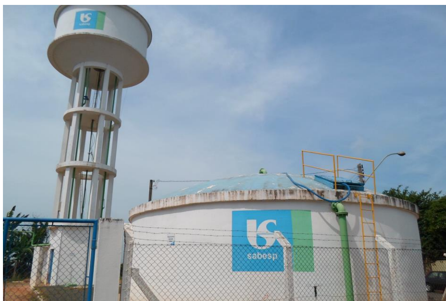
Figura 35 - Reservatórios de 70 m 3 e 250 m 3 (da esquerda para direita).
