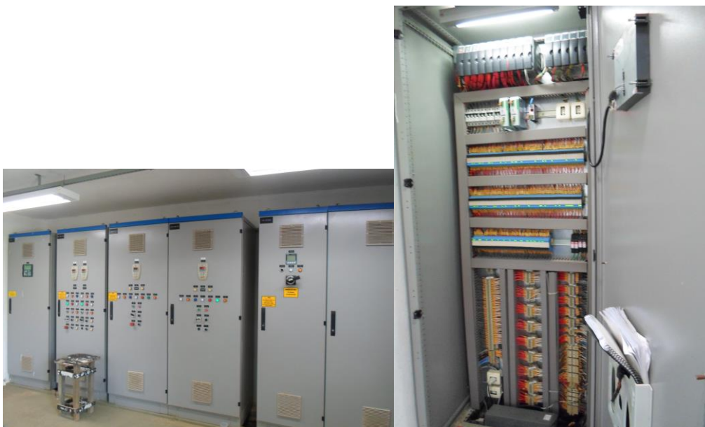
Figura 54 - Painéis de Telecomando e Automação.
