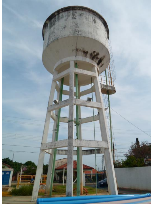
Figura 31 - Reservatório de 100 m 3 (Unidade de Filtragem).
