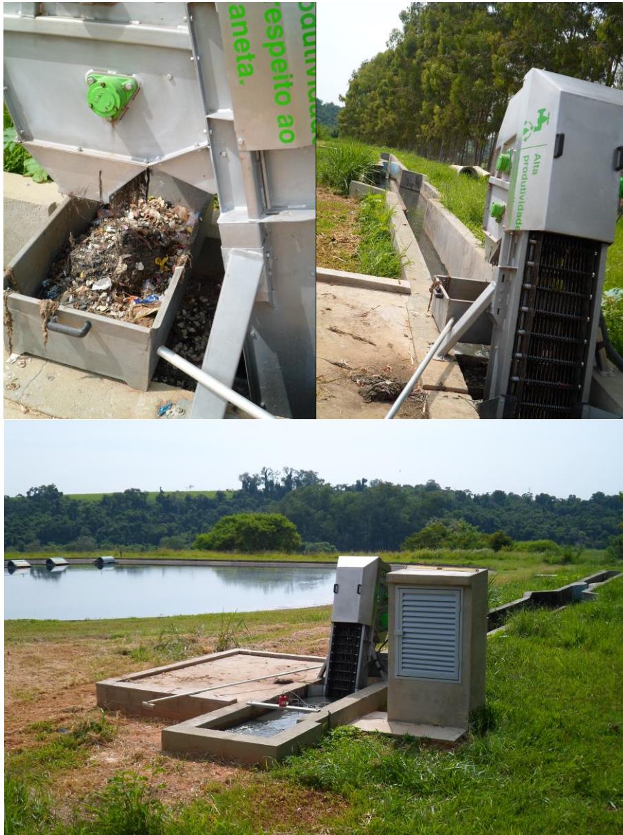
Figura 45 – Vista da Entrada do Esgoto com Tratamento Preliminar (gradeamento).
