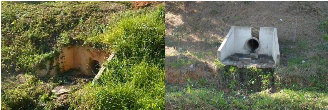
Figura 72 – Saídas das Galerias de Águas Pluviais.
