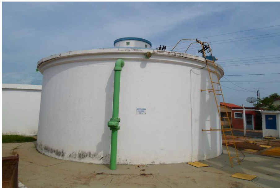
Figura 32 - Reservatório de 200 m 3 (Unidade de Filtragem).
