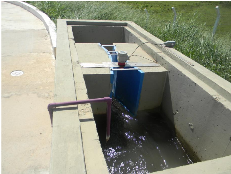
Figura 53 – Dosagem de Hipoclorito de Sódio e Medidor de Vazão do Efluente Tratado.
