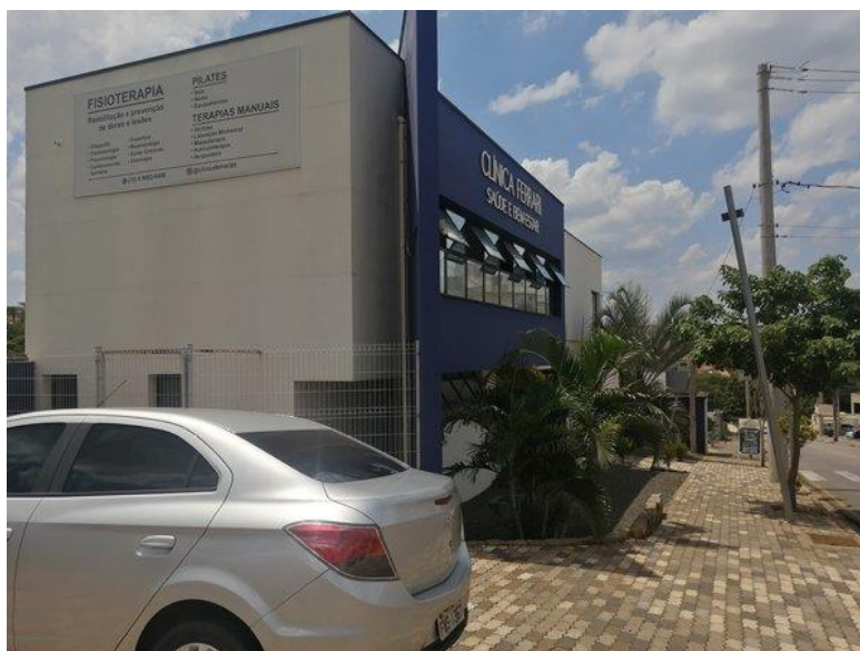
Figura 7.45 – Estabelecimento de serviços - Rua Roque Issa
