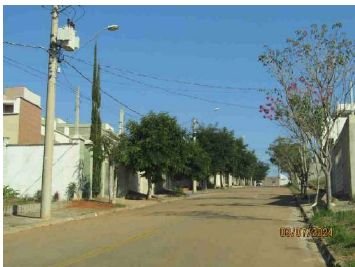
FOTO 3: Área urbanizada com serviço de iluminação pública.
