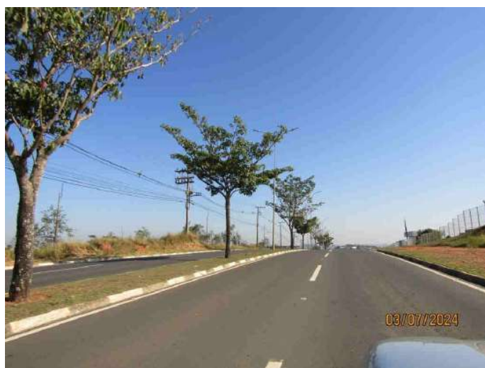
FOTO 6: Área urbanizada com serviço de energia elétrica.
