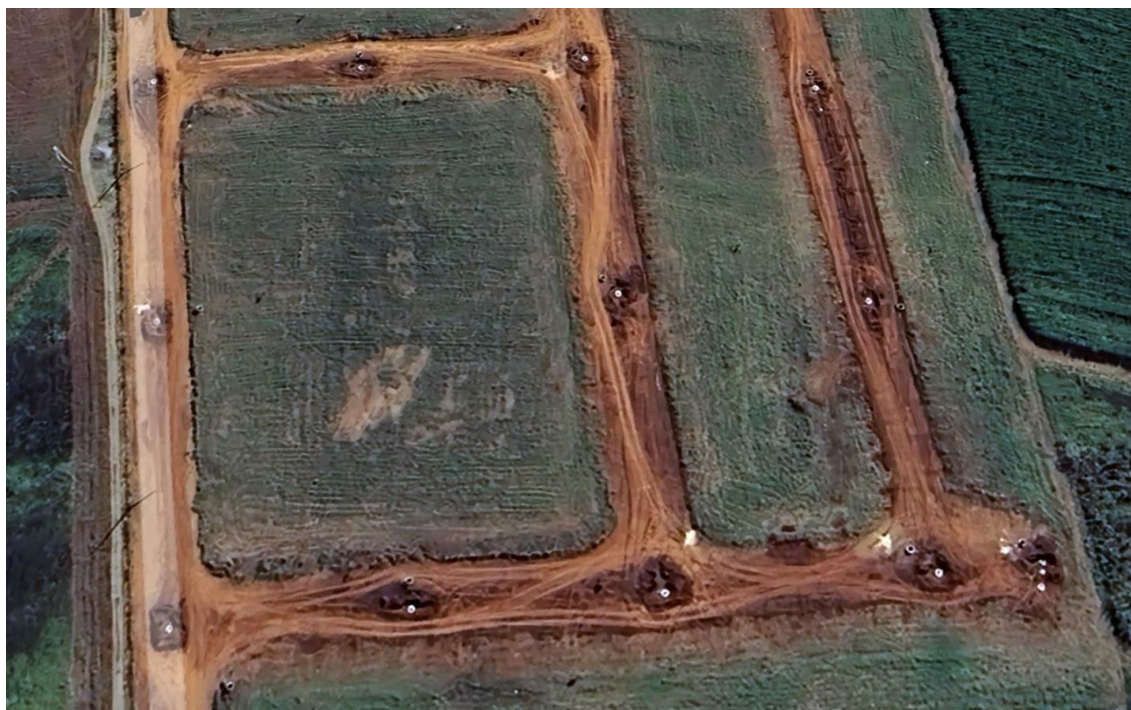
Figura 6.7 – Loteamento sendo implantado. Notar a abertura das ruas e obras da galerias pluviais e rede de esgoto.
