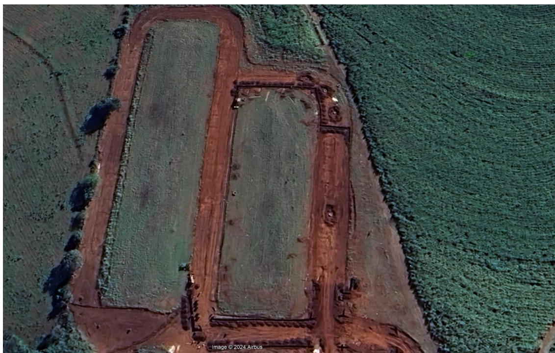
Figura 6.12 – Loteamento sendo implantado. Notar a abertura das ruas após a travessia sobre curso d'água.
