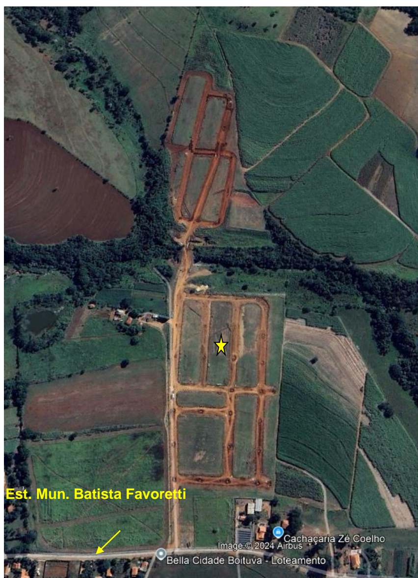
Figura 3.1 – Principal via para acesso ao loteamento residencial em implantação.★
