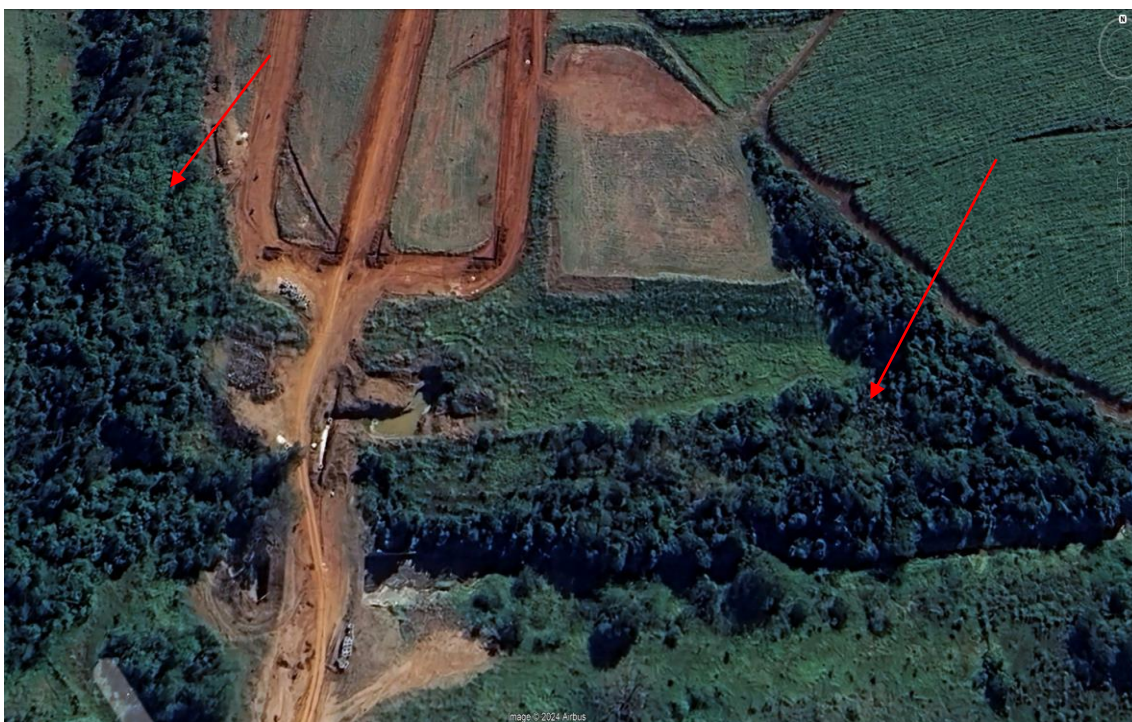
Figura 6.10 – Loteamento sendo implantado. Notar a abertura das ruas e obras da travessia sobre curso d'água, com a implantação da Avenida 1. Notar Vegetação em APP (Área Verde 1) que será preservada em Área Verde.
