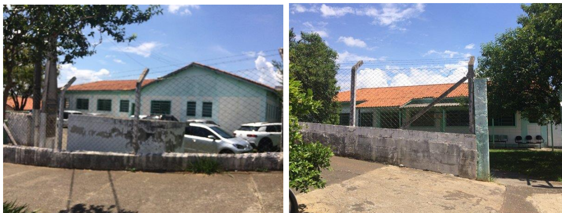
Figuras 6.51 e 6.52 – UBS Novo Mundo - Rua Orlando Maciel de Lima/ Rua Carmela Tirabassi Coan.
