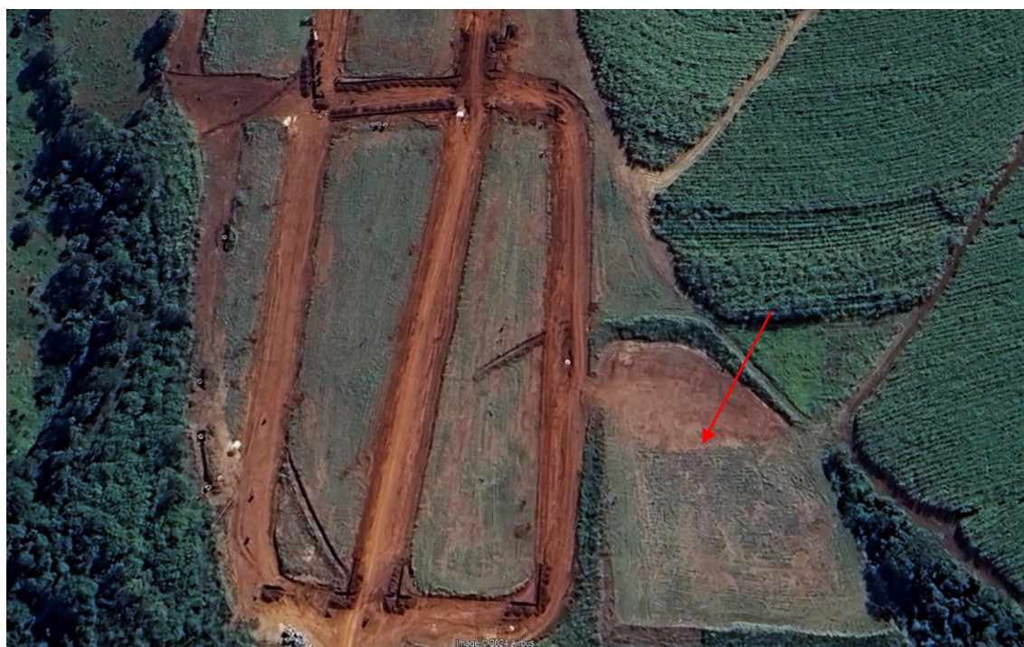
Figura 6.11 – Loteamento sendo implantado. Notar a abertura das ruas após a travessia sobre curso d'água. Notar Sistema de Lazer 1.
