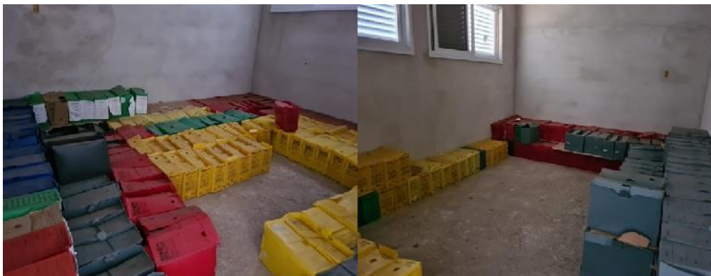
Prontuários de pacientes armazenados de maneira inadequada no interior do edifício
