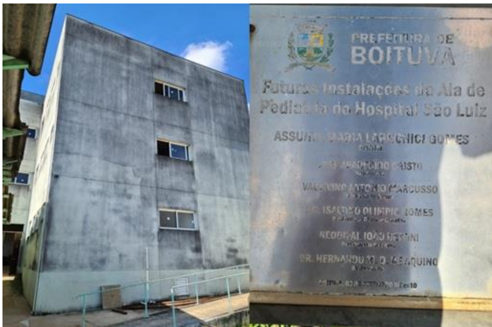
Vista externa da obra de ampliação do Hospital São Luiz
