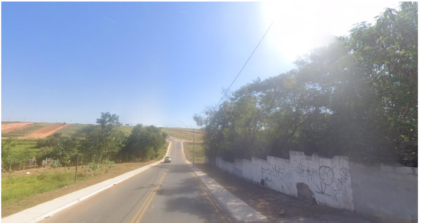
FOTO 12: Via existente no bairro Parque Novo Mundo que conecta a travessia.
