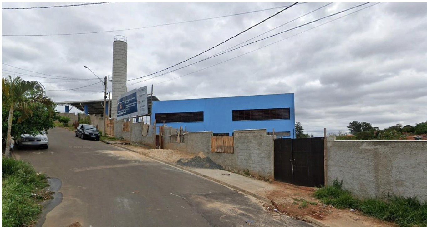
FOTO 15: Escola em construção no bairro Parque Novo Mundo.
