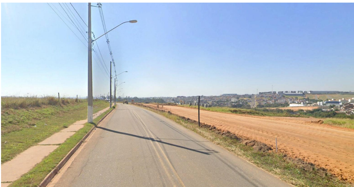
FOTO 04: Infraestrutura – Estrada Municipal Vicente Teles de Miranda BTV
