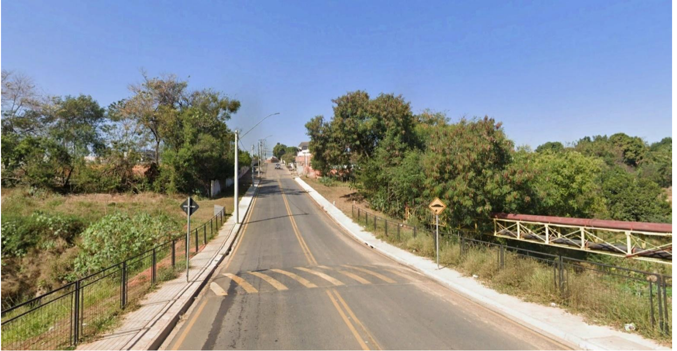
FOTO 09: Infraestrutura – Travessia que interliga o Jardim São Roque ao bairro, já consolidado, Parque Novo Mundo.
