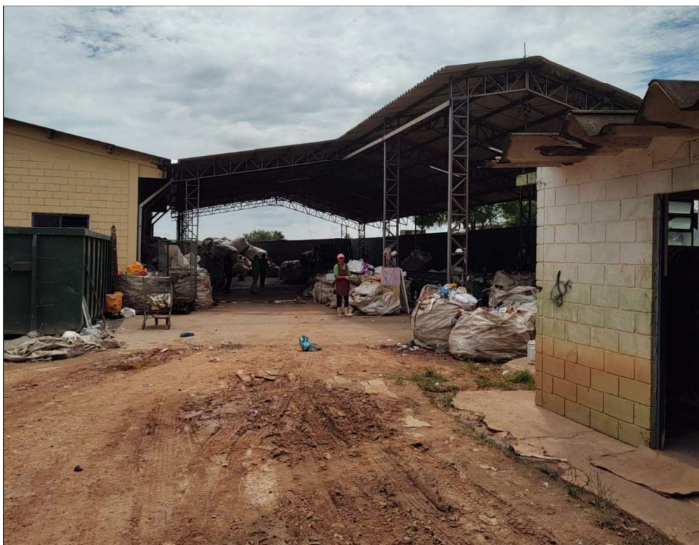
Figura 27 - Galpão de Triagem da Coopera Boituva
