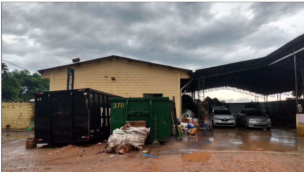
Figura 26 - Galpão de Triagem da Coopera Boituva
