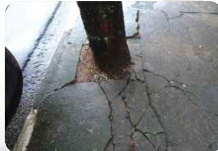
Foto 07: Calçada danificada pelo tamanho inadequado do canteiro
