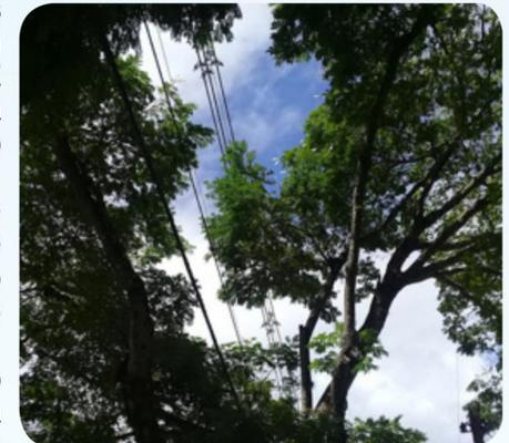
Foto 05: Rede elétrica passando no meio da árvore e ramos em contato direto com a fiação
