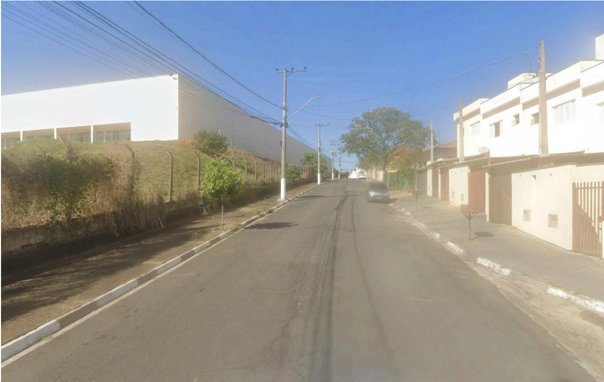
Figura 2.3d: Iluminação na Rua Eurides Laureano
