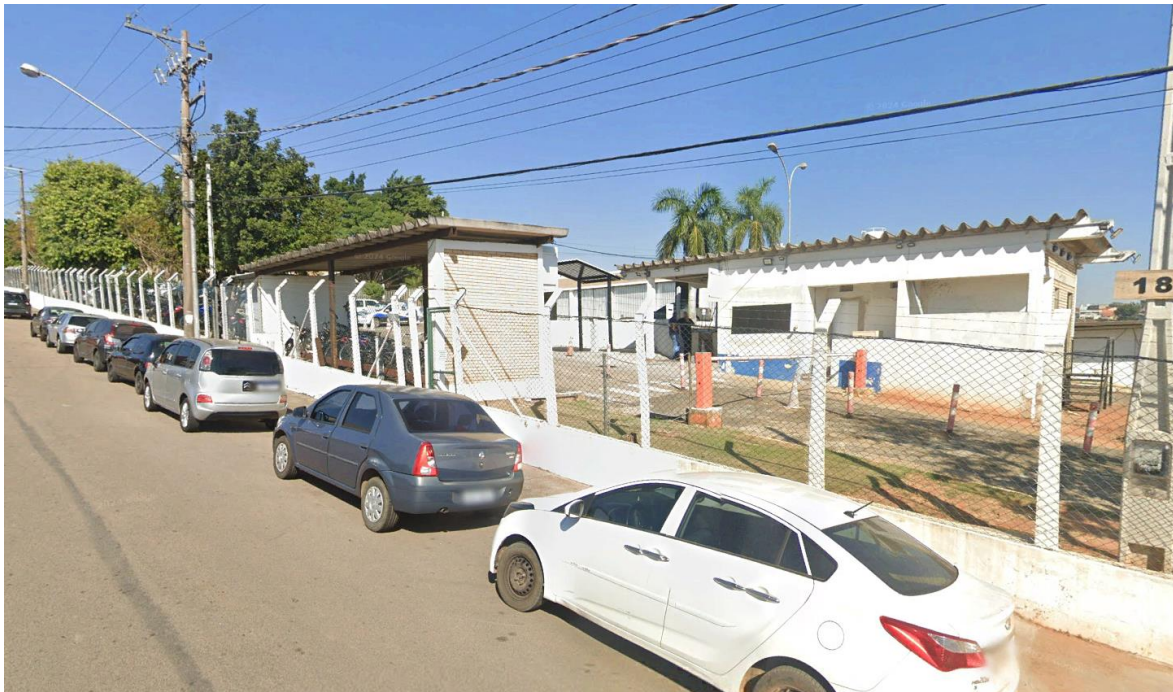
Figura 2.2e: Divisa Lateral do Empreendimento – Rua Antônio Galvão Pacheco – Galpões industriais
