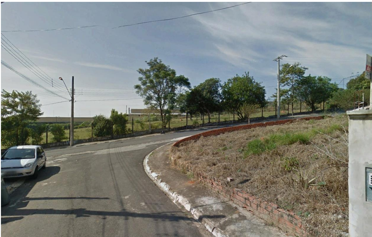
Figura 2.3e: Passeio Estreito na Rua Osvaldo Pacheco
