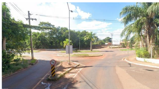
FOTO 1. Av. Pedro Eid, sentido Av. Joaquim Trujillo
