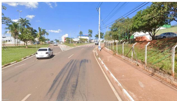
FOTO 1. Av. Joaquim Trujillo, sentido Rua Zélia de Lima Rosa
