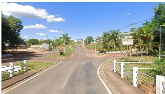
FOTO 3. Av. Joaquim Trujillo, sentido interseção 2
