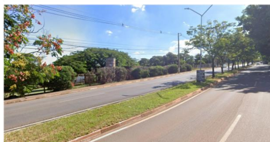
Avenida Joaquim Trujillo
