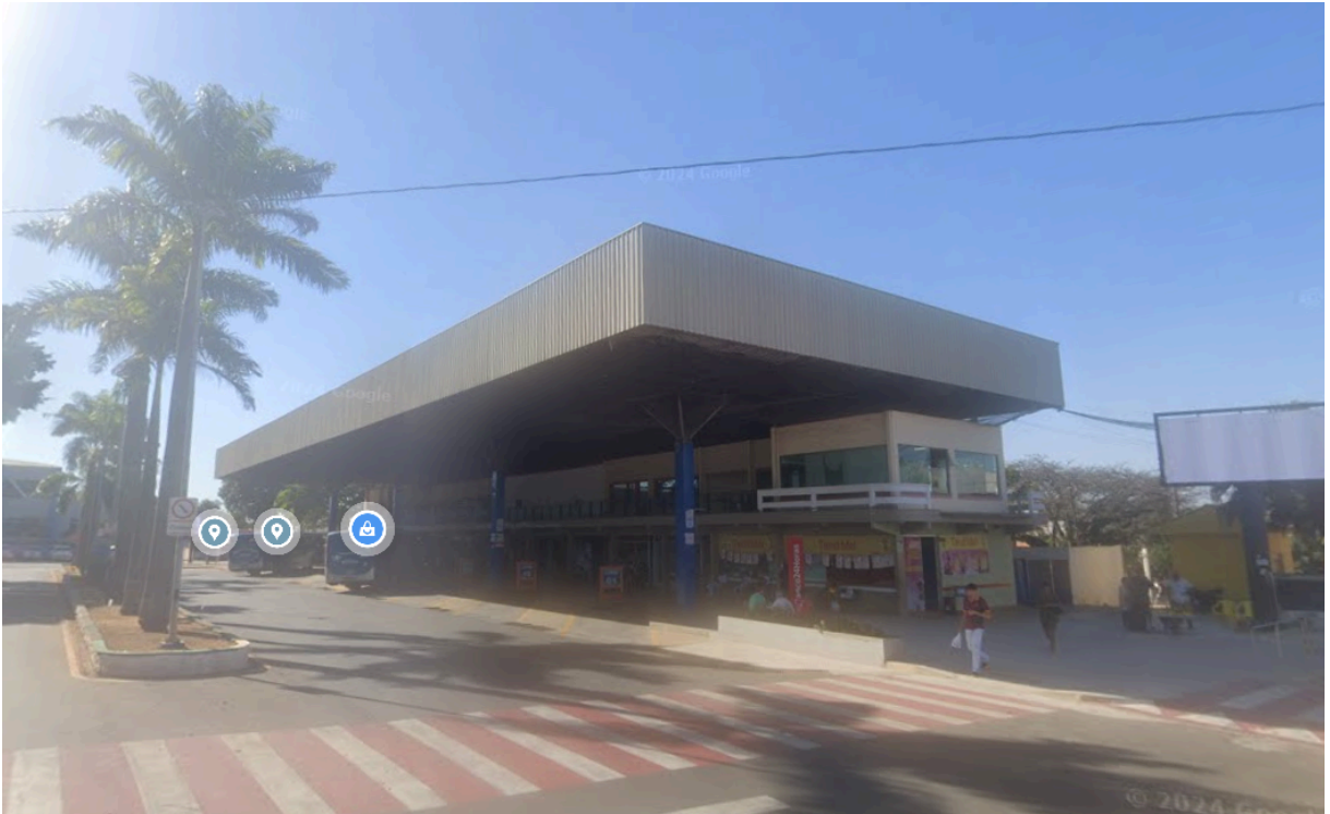
Foto - Faixa de pedestre em nível
