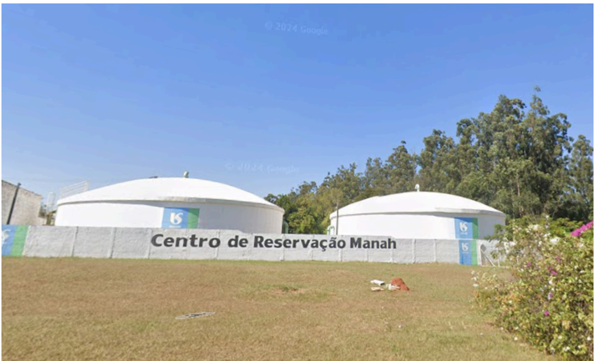
Centro de Reservação Manah de Água (Sabesp) - Av. Mario Pedro Vercellino n° 559
