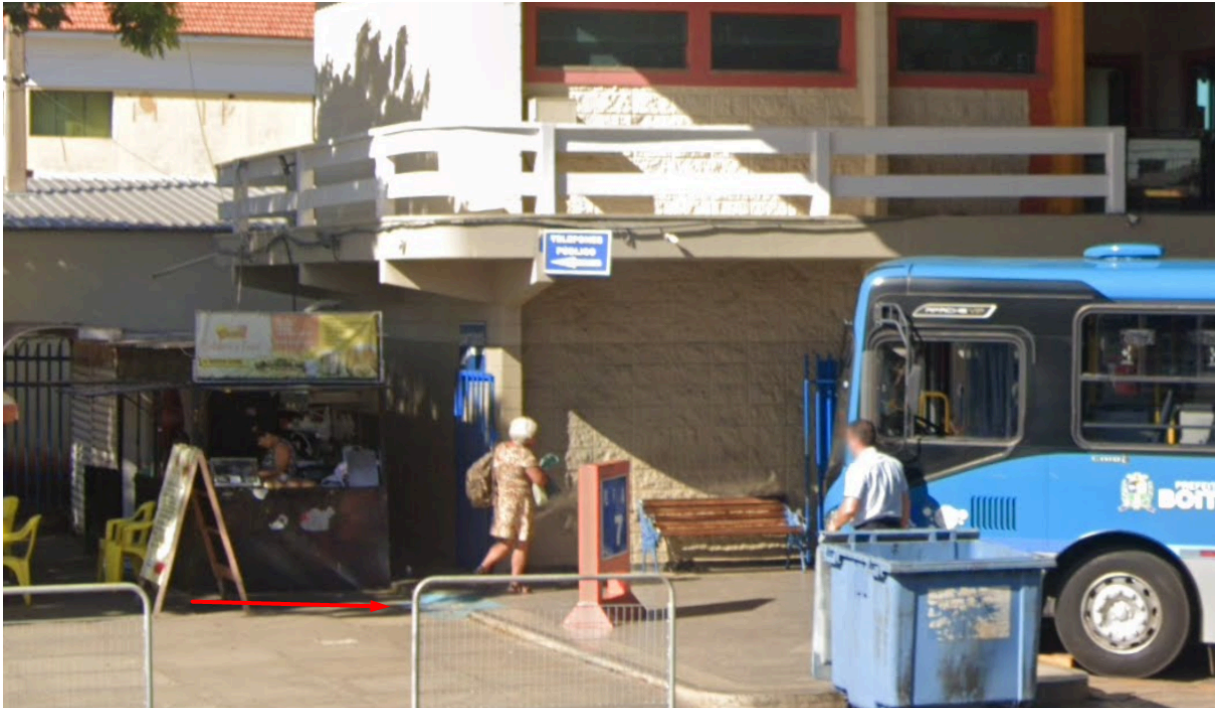
Foto - Rampas de acesso (seta vermelha)
