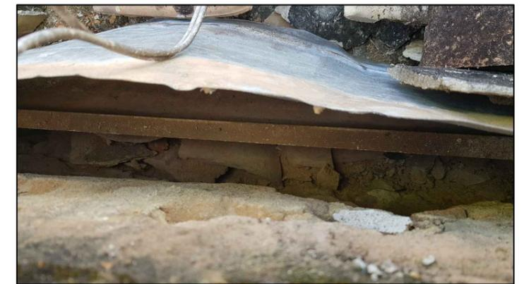
Vão entre o rufo e a platibanda, fazendo com que a água entre em contato com a parede
