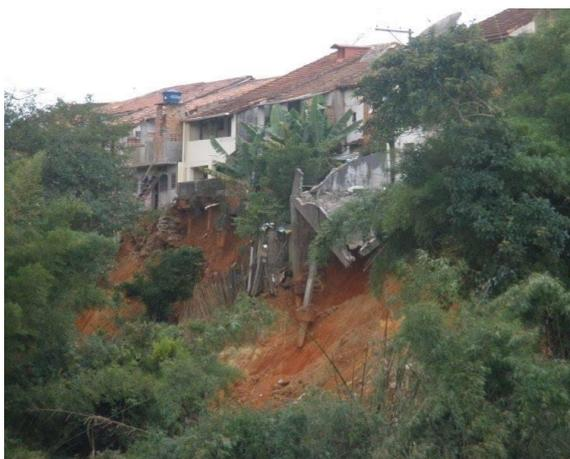
**Foto 2- Fundos dos terrenos de casas em estilo colonial da Rua do Carvalho onde houve solapamento e deslizamentos.**
