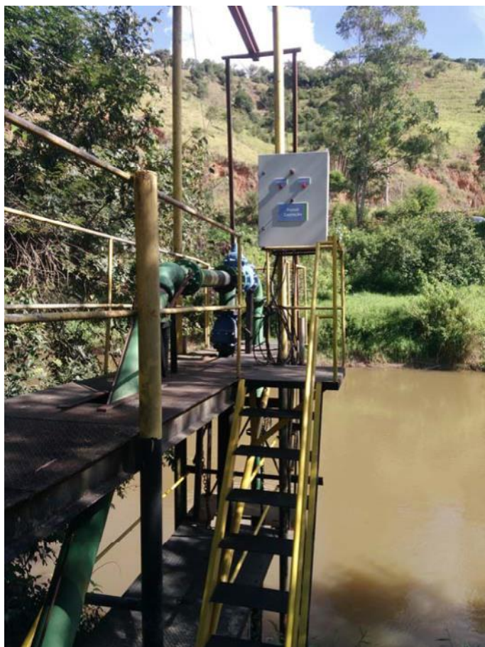
Foto 01 – Captação de água no rio Paraitinga
