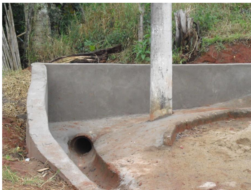
Foto 12 – Estrutura de drenagem superficial com vistas à proteção de encosta contra erosões e deslizamentos. (Fonte: Plansan 123)
