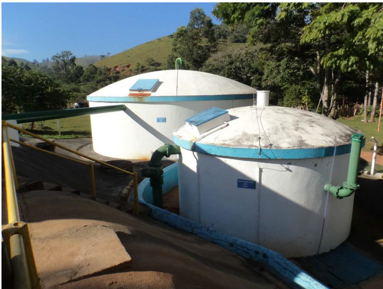
Foto 03 – Reservatórios R 4.1 e R 4.2 9 (ETA).
