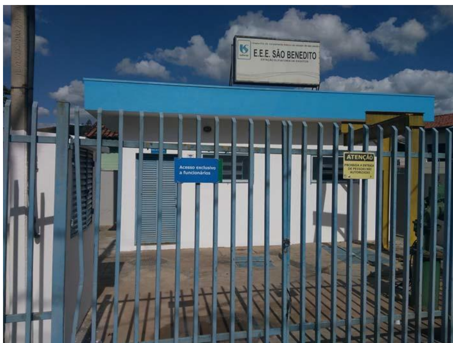
Foto 05 – Estação elevatória de esgoto São Benedito
