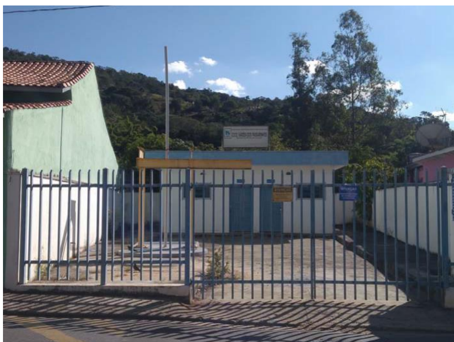
Foto 06 – Estação elevatória de esgoto da Várzea dos Passarinhos
