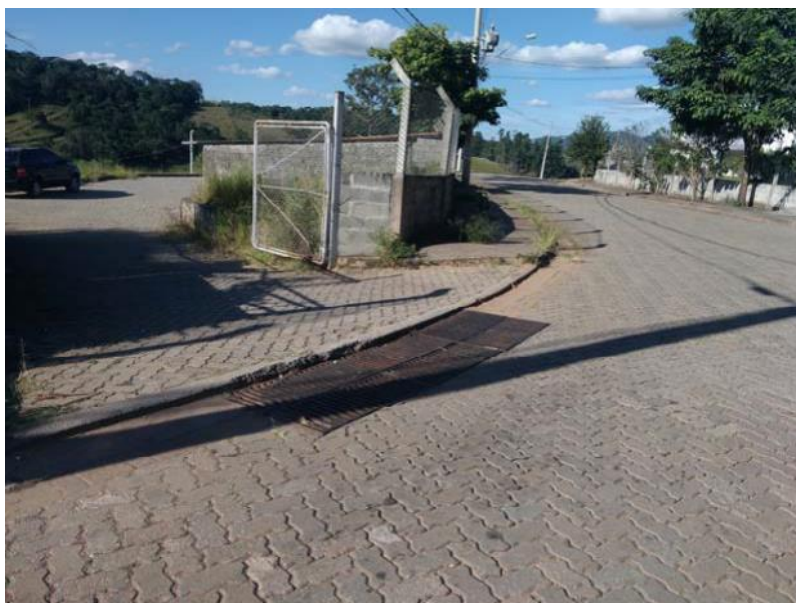
Foto 11 – Boca de lobo responsável pela coleta das águas pluviais que escoam pelas sarjetas. (Fonte: PMSLP, 2018)
