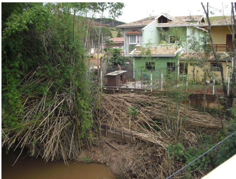
Foto 10 – Ocupação das margens do Rio Paraitinga na área urbana do Município. (Fonte: Plansan 123)
