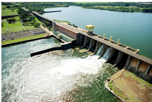
Foto 4 - Usina Hidrelétrica de Ibitinga
