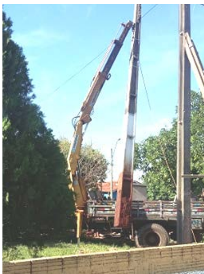
Construindo nova caixa Mudando o poste de lugar Religando a energia
