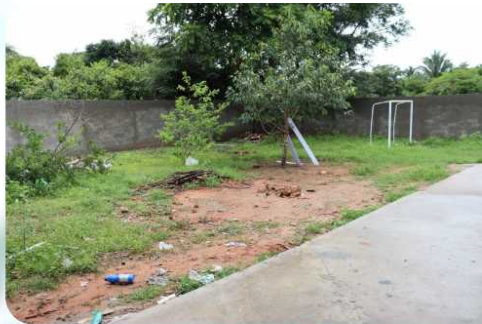
Conclusão do muro
