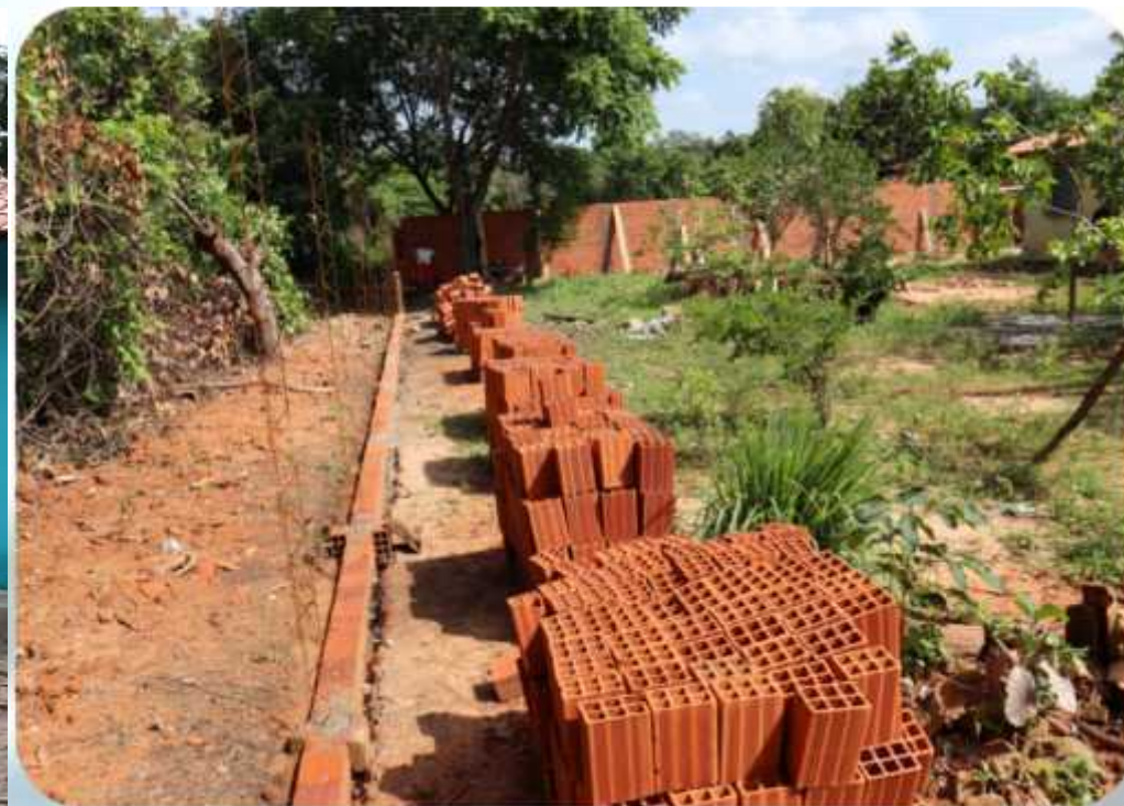
Construção do muro da Escola Dr. Noronha Almeida
