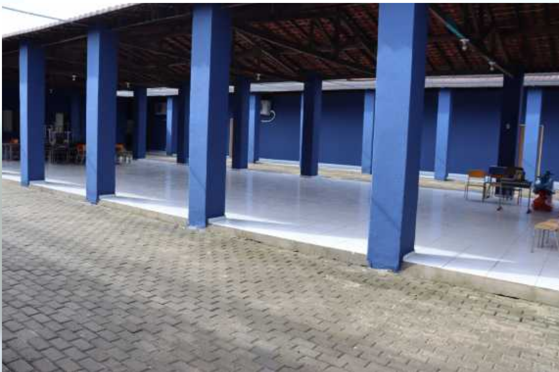
Conclusão da reforma da Escola Prof. a Antônia Noronha
