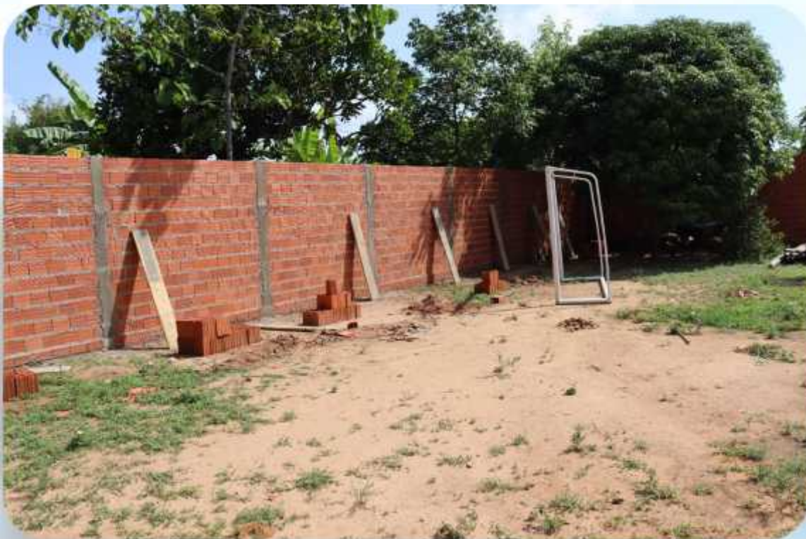
Construção do muro da Escola Municipal Dr. Noronha Almeida
