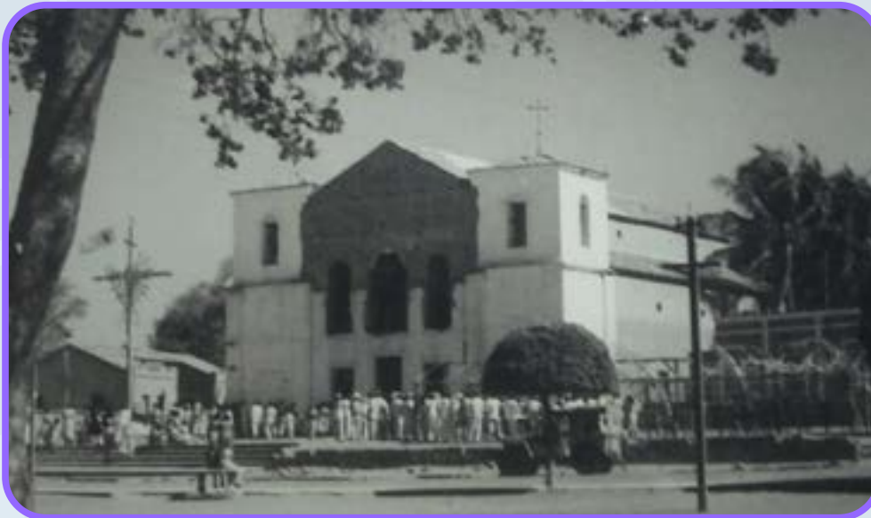
Igreja de Nossa Senhora da Conceição em reforma no ano de 1946. Fonte: Arquivo do Solar da Estrela Marrom.
