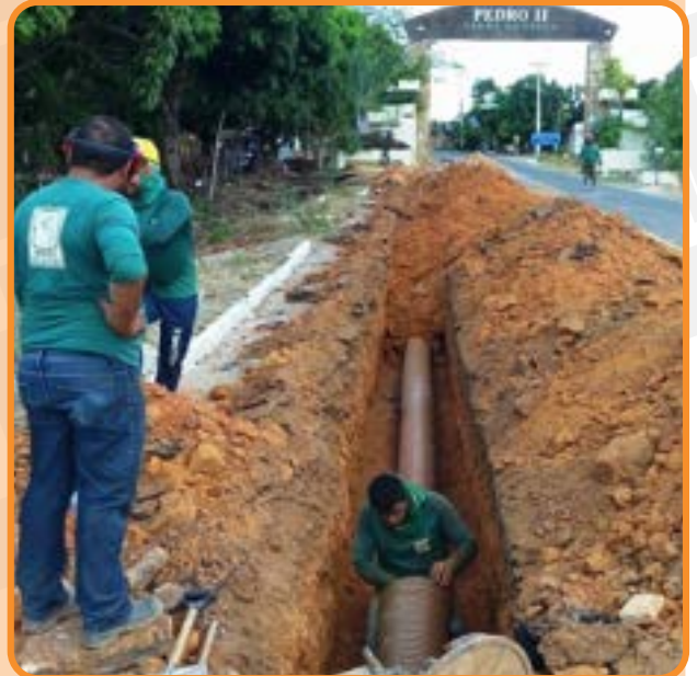
Obra de esgoto em Pedro II.
