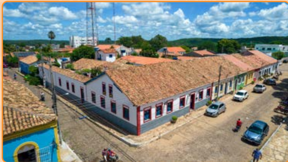
Casarão do Coronel Domingos Mourão Filho, conhecido como Solar da Estrela Marrom. Foto: Samuel Lima de Sousa (2025).
