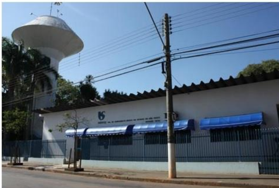
SABESP Estação de Tratamento de Água
