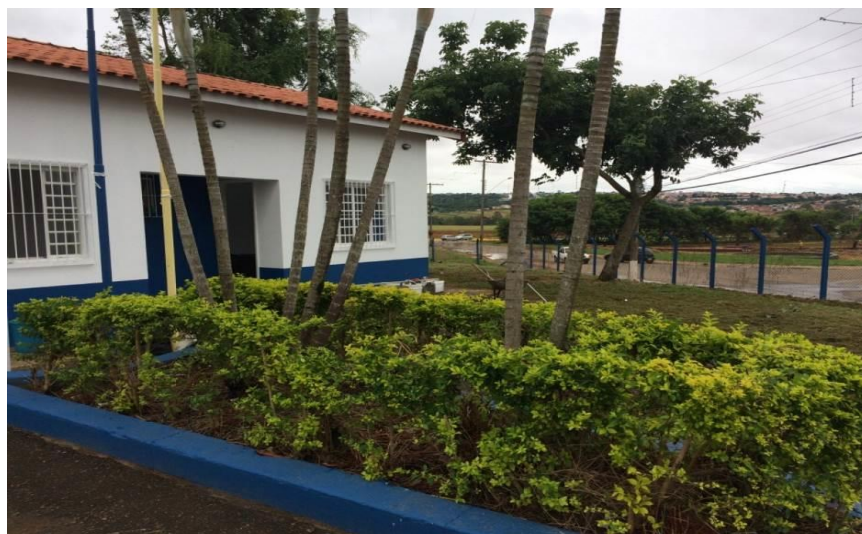
Guarda Civil Municipal de Tatuí – Base Bairro Jardim Santa Rita
