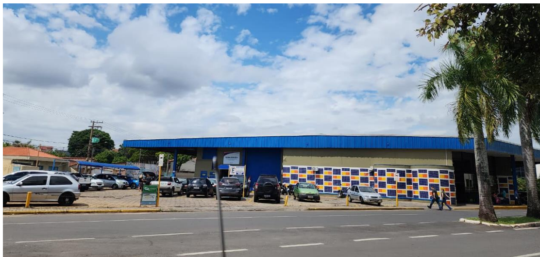
Terminal Rodoviário de Tatuí
