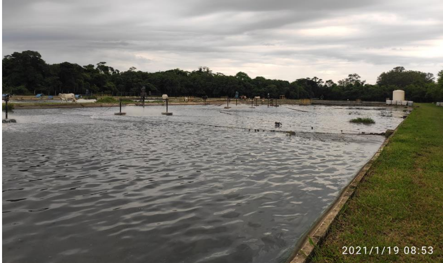
Figura 5-15 – Lagoas aeradas da ETE CEAGESP Fonte: CONSÓRCIO CM (2021)
