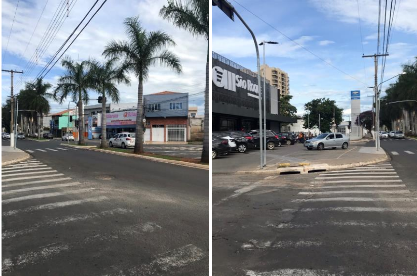
Figura 7-10 - Ponto de alagamento 2 Fonte: CONSÓRCIO CM (2021)
