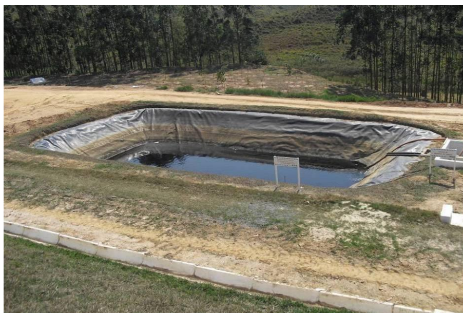
Foto 18 – Tanque Reservatório de Líquidos Percolados – Chorume
