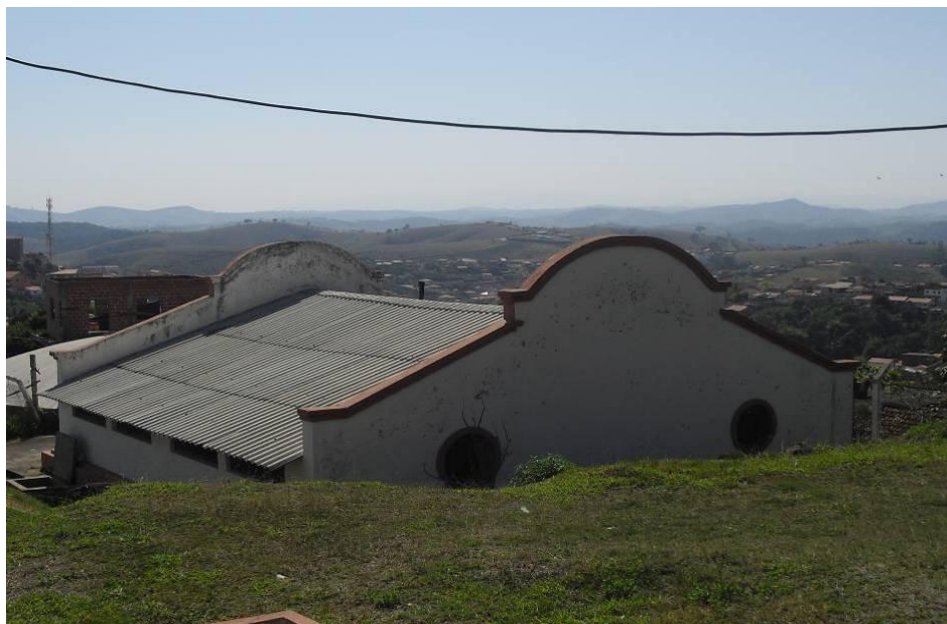
Foto 08 – Reservatório da Capela
