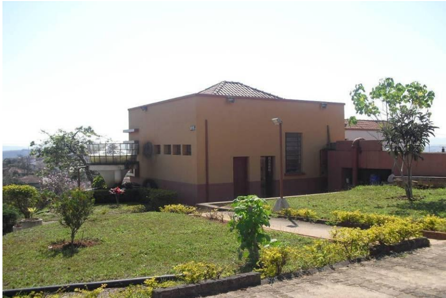
Foto 02 – ETA Central do Município de Cunha
