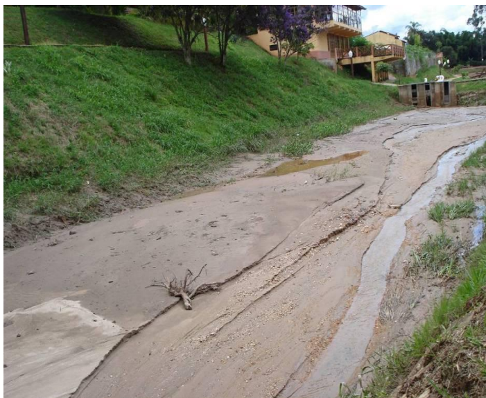
Foto 19 – Assoreamento no Parque Lavapés - Bairro Lavapés (Fonte: GEL Cunha)
