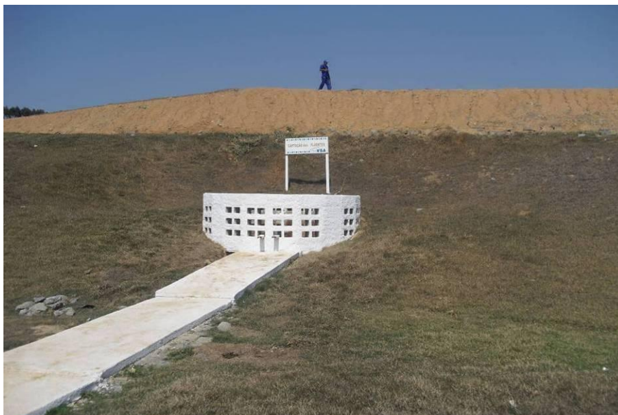
Foto 17 – Poço de Captação de Líquidos Percolados – Chorume
