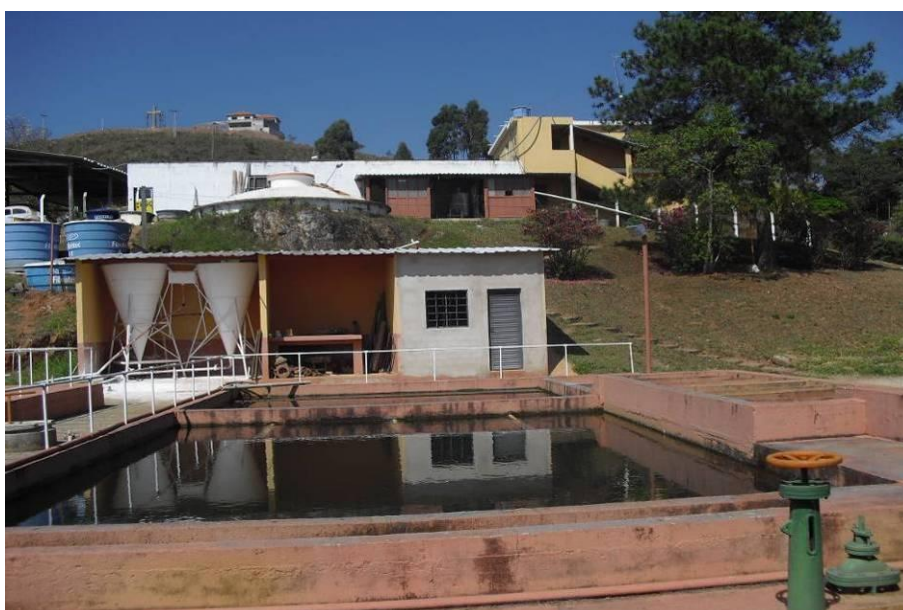
Foto 05 – Vista geral da ETA Central de Cunha
