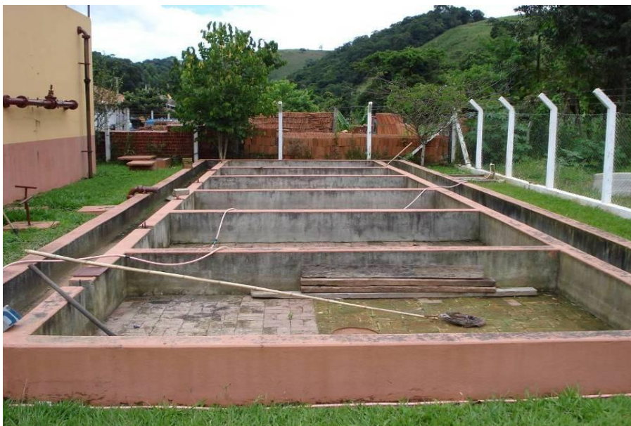
Foto 12 – Leito de secagem do lodo gerado no sistema (Fonte: GEL Cunha)
