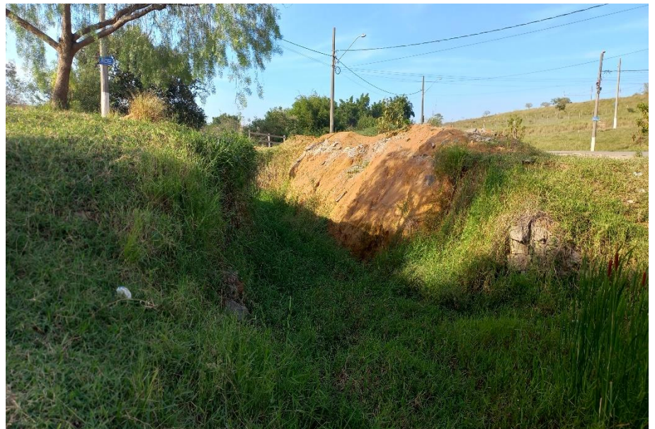
Foto n.º 2 – Aspecto da travessia 03 em observação da jusante para a montante.
