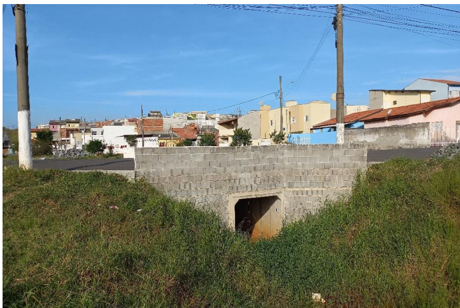
Foto n.º 3 – Registro da travessia 02 em posição oposta à foto anterior.
