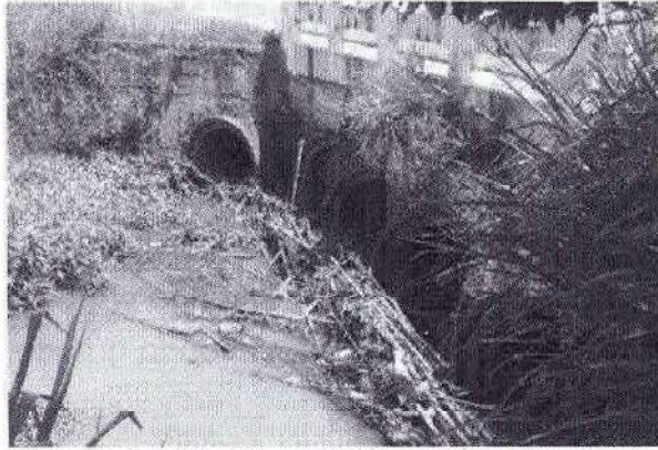
Figura 6: Vista Geral da Travessia sob a Rua Túlio Giulio (Montante).
